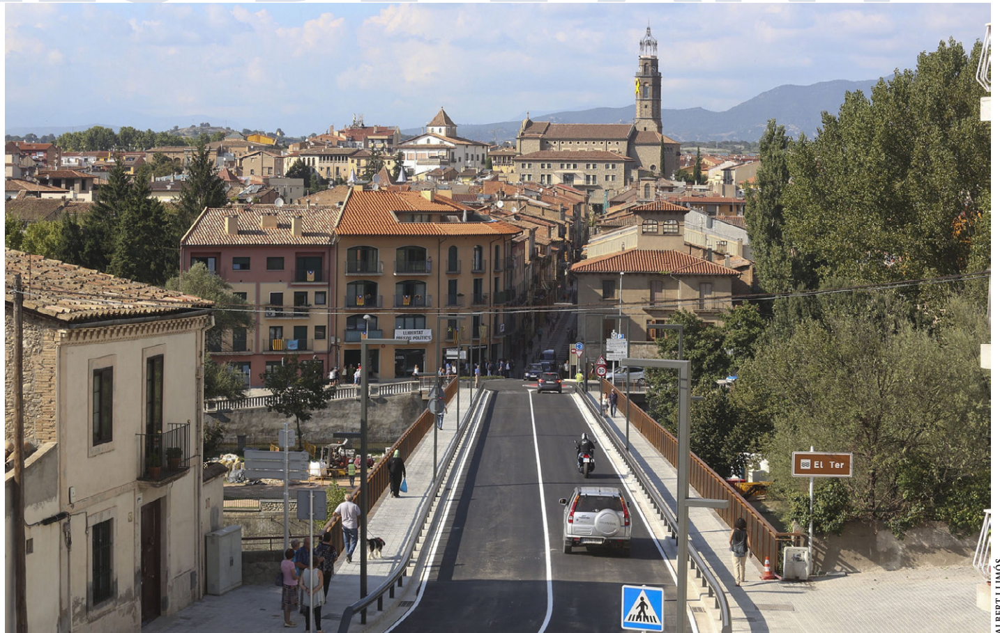
Aspecte actual del pont de Manlleu: ara els carrils de circulació fan tres metres i les voreres s'han ampliat fins a 1,5 cadascuna
