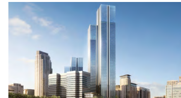
SOUTH QUAY PLAZA E14 9SW
