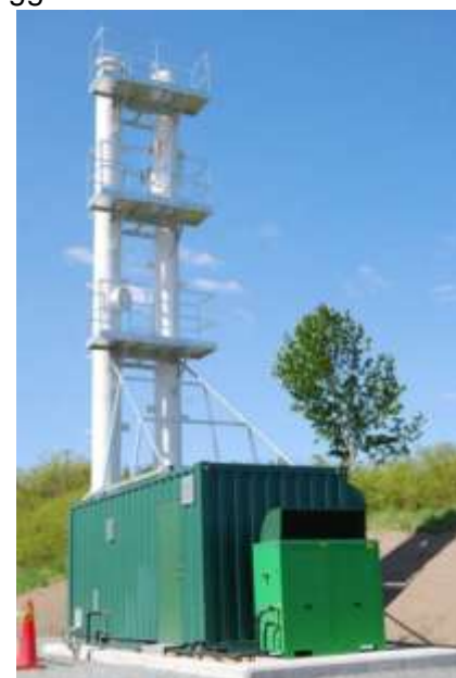
Figur 6. Skjemaskisse Greenlanes vannskrubberteknologi (over), på et ferdig installert anlegg (til høyre).
