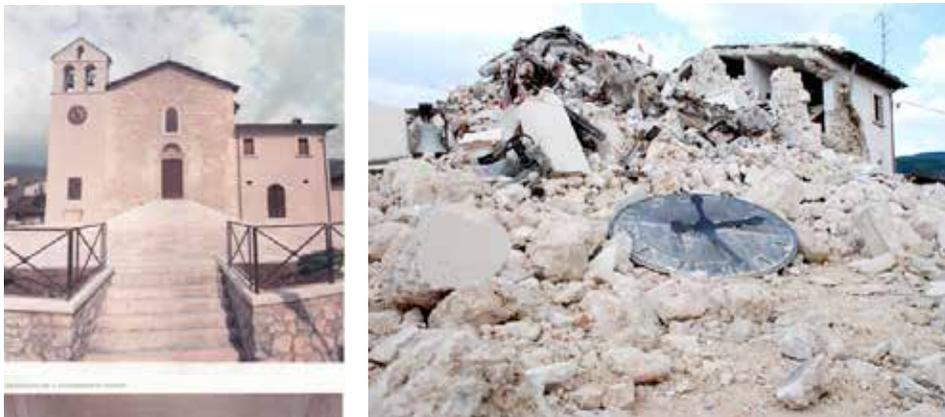
**Figura 5. Chiesa parrocchiale di Tempera (AQ) oggetto di un intervento di sostituzione della copertura, e di iniezioni cementizie (nel 1984). Immagini prima e dopo il sisma del 2009.**
