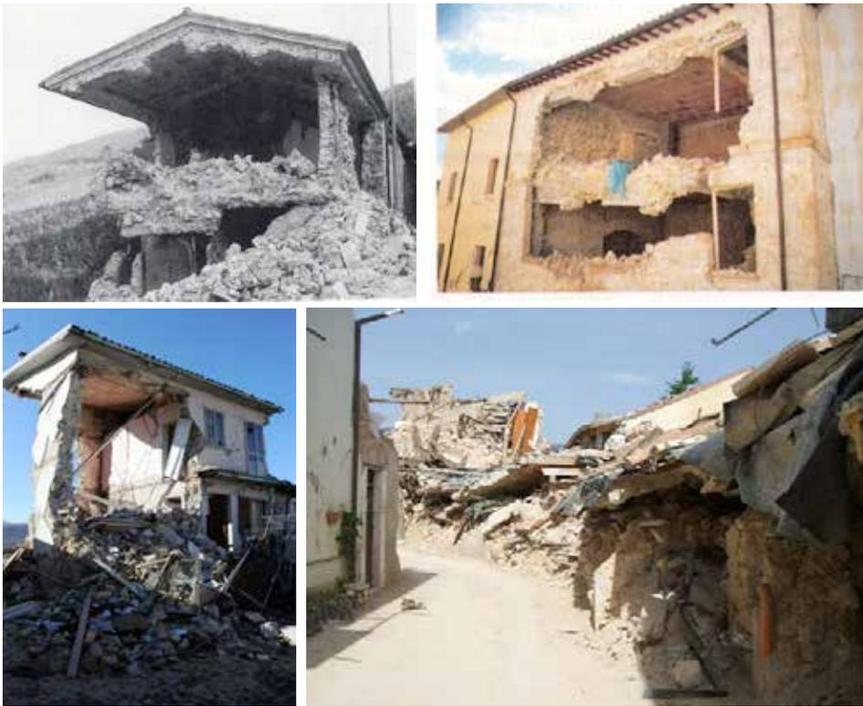
**Figura 4. Sisma Umbria-Marche e sisma Abruzzo: edifici in muratura di scarsa qualità meccanica nei quali erano stati sostituiti solai e coperture lignee con elementi in latero-cemento.**
