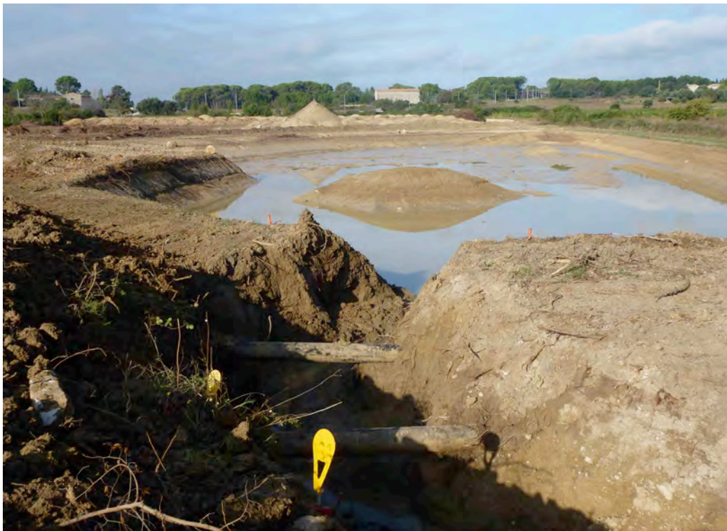
Photo 2. Photo 1. Le bassin de rétention à l'Est du Mas de Caylus, le 28 août 2015
