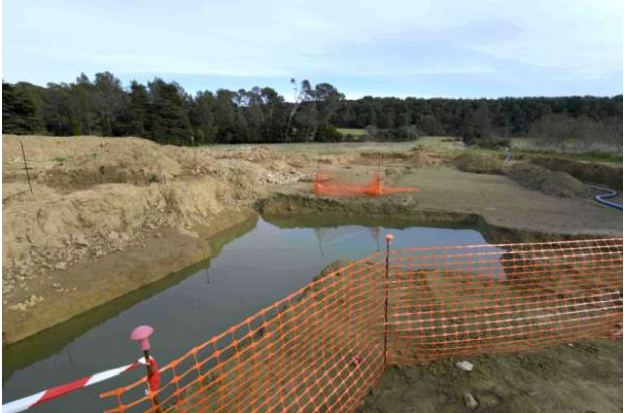
Contexte environnemental très humide dans la zone ouest du Mas de Caylus avec une nappe affleurante à moins d'un mètre du sol (31 mars 2015) Photo T.Ruf
