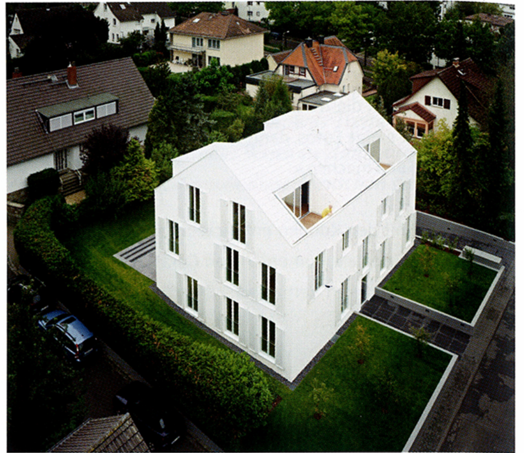
Wohnhaus am Heiligenstock
