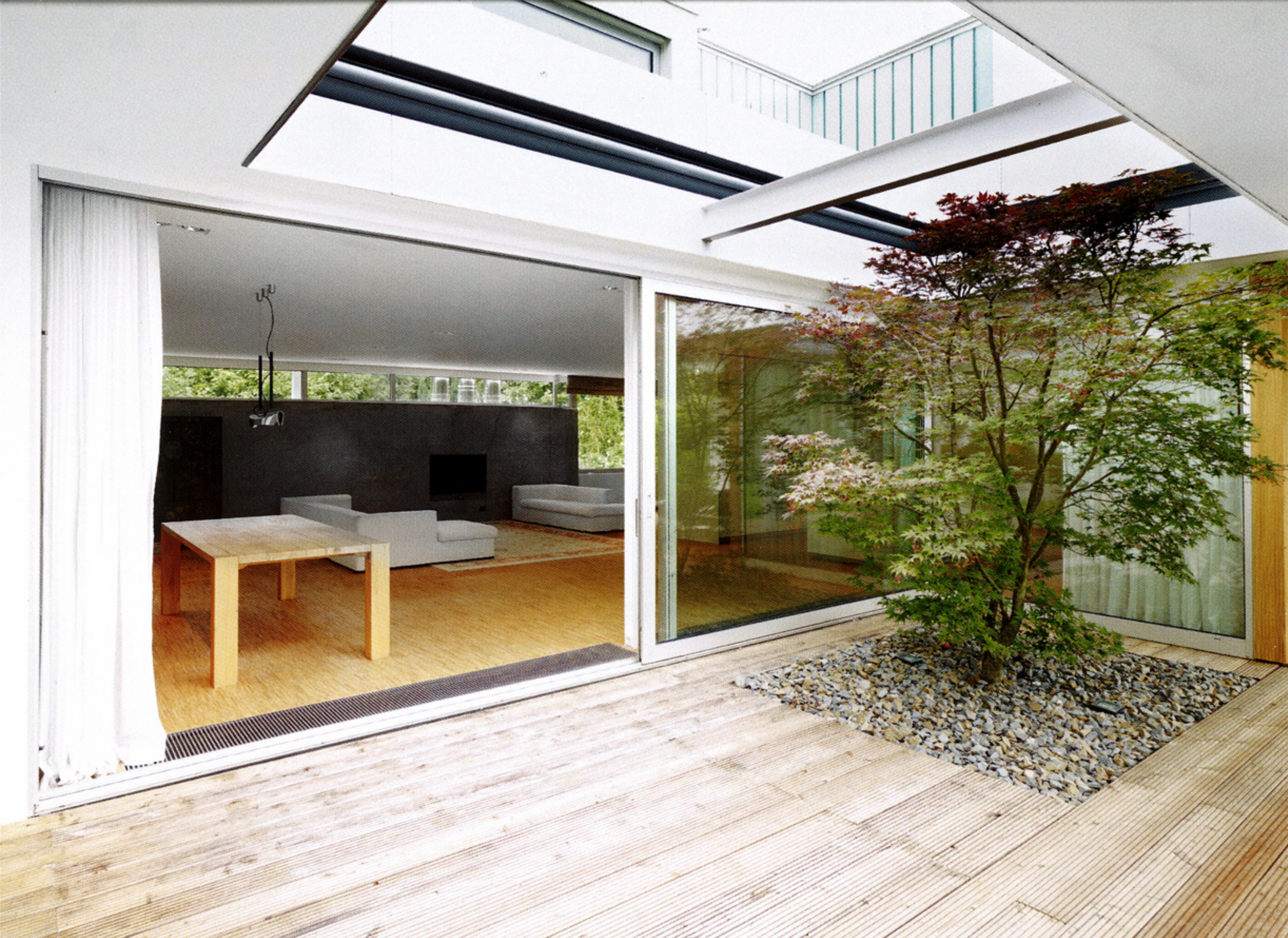
Bereich der überdachten Terrasse wurde das Flachdach partiell geöffnet, um mehr Licht in das Gebäudeinnere zu bringen.
