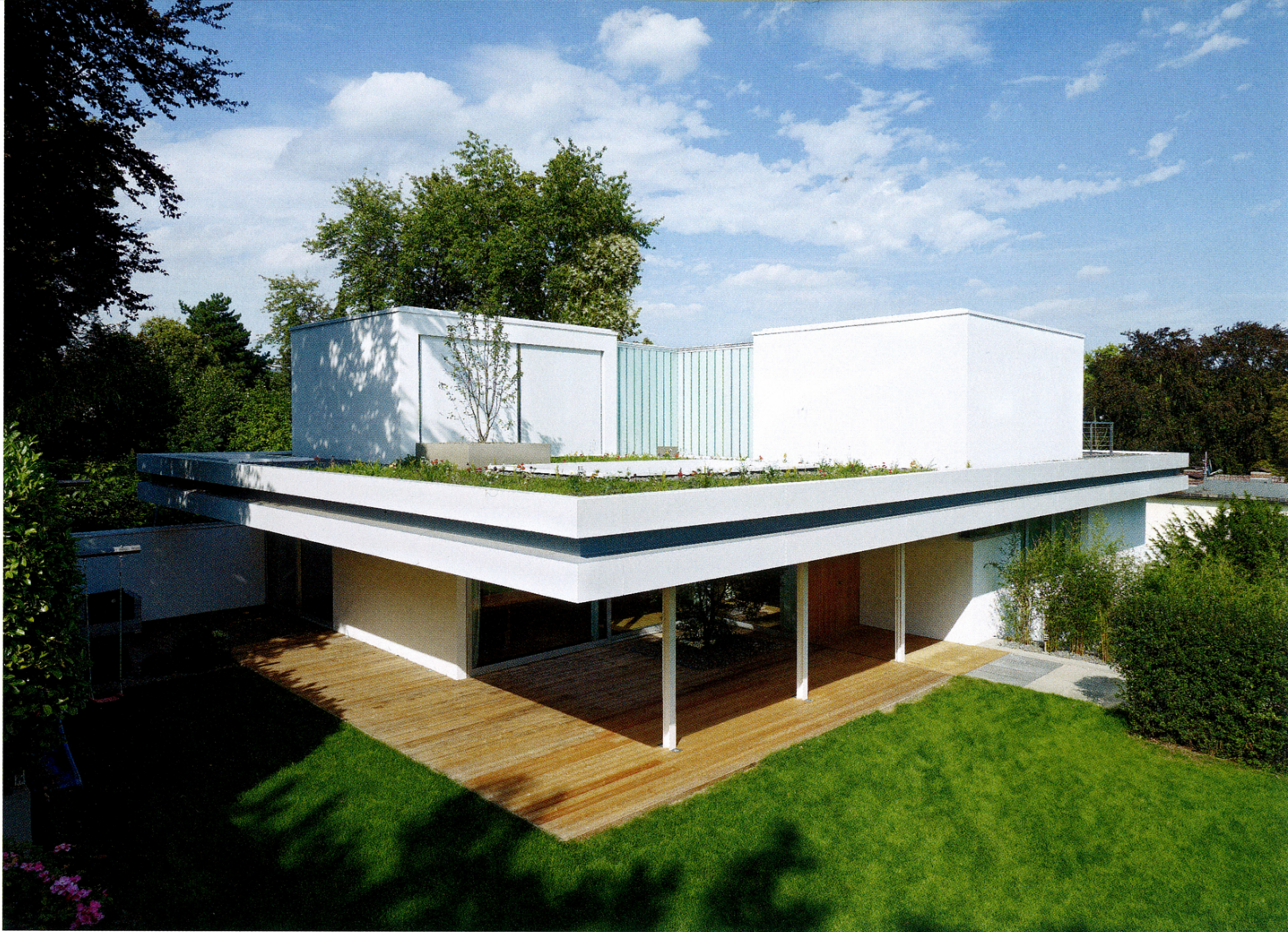
Die Aufstockung ist in drei kubische Baukörper aufgelöst.
