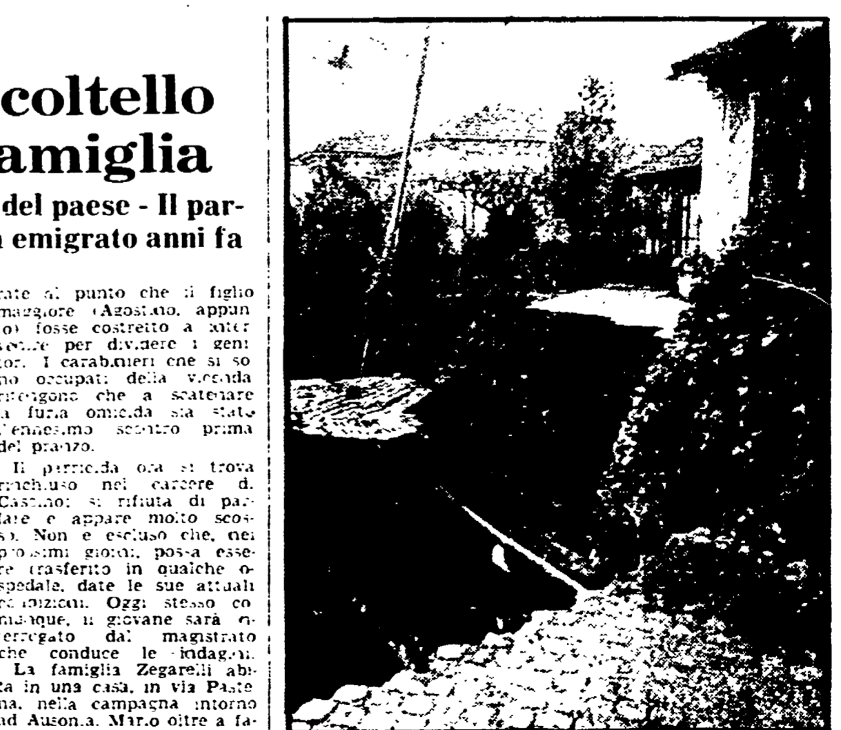
S'ALLARGA LA VORAGINE. La voragine s'ingrandisce sempre più. In via Formia, a via Gordiani, si sta allargando ingoiando la strada e lambendo pericolosamente la base di tre palazzine. Il fenomeno di smottamento è stato provocato dal crollo di alcune gallerie scavate abusivamente nel sottosuolo per allargare la strada. NELLA FOTO: La voragine che minaccia di ingoiare alcuni palazzi
