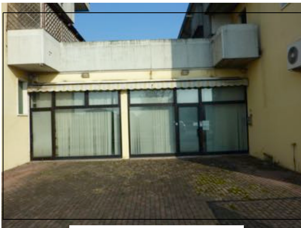
FOTO 2 - esterno (Via Monte Grappa, 27)
