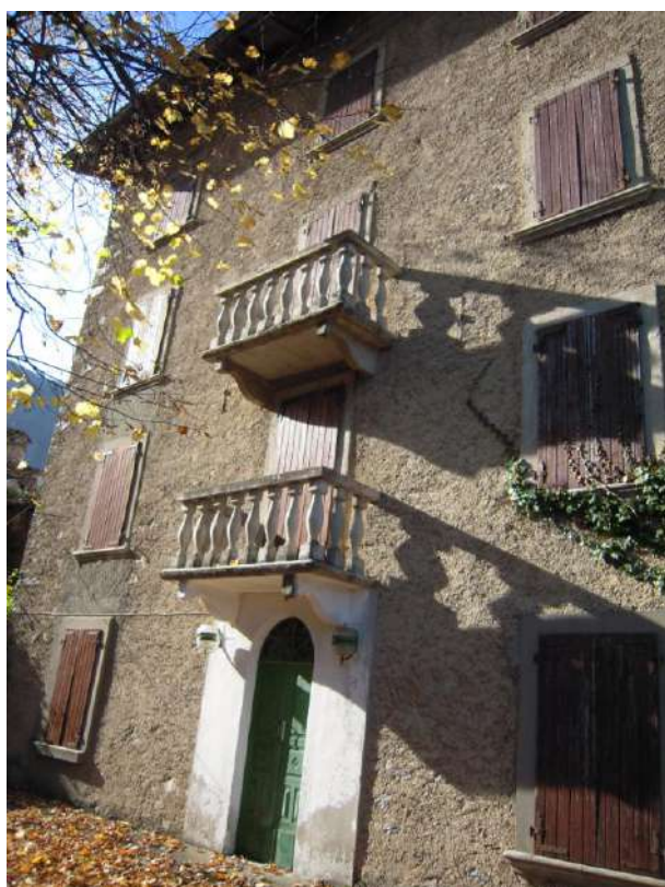
Foto 2 – Immobile lato Sud
