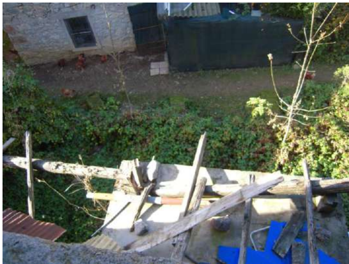
Foto 17 – Particolare tettoia lato nord
