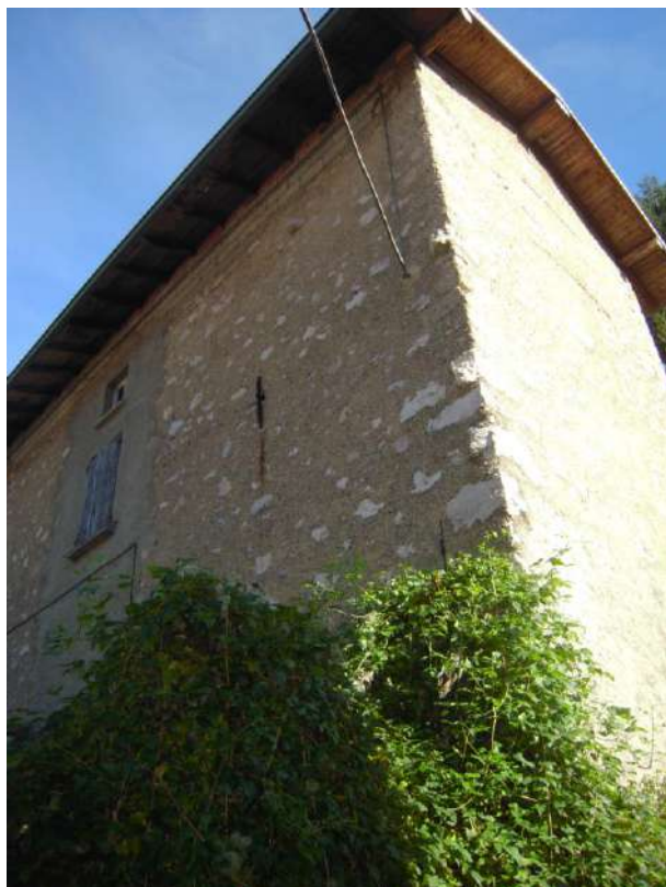
Foto 17 – Particolare copertura lato Nord - Est
