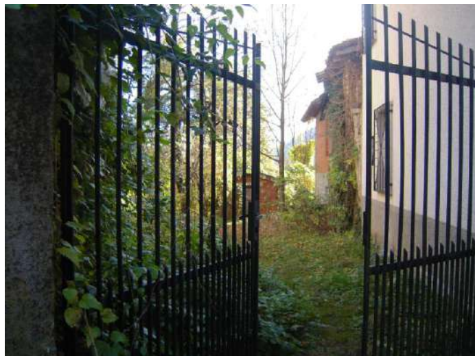
Foto 1 – Particolare accesso al fabbricato lato nord
