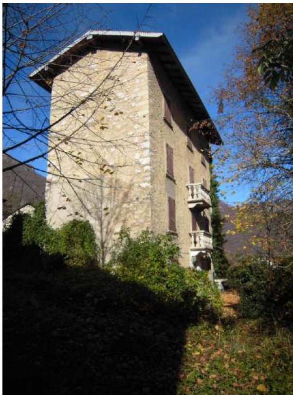
Foto 1 – Immobile lato Sud – Ovest
