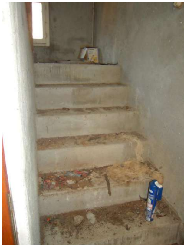
Foto 13 – Vano scala per accesso alla sottotetto
