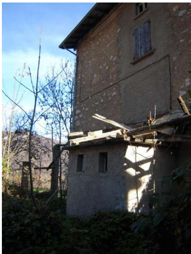
Foto 18 – Particolare immobile lato Nord
