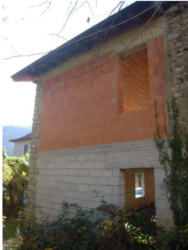
Foto 3 – Vista lato Est immobile
