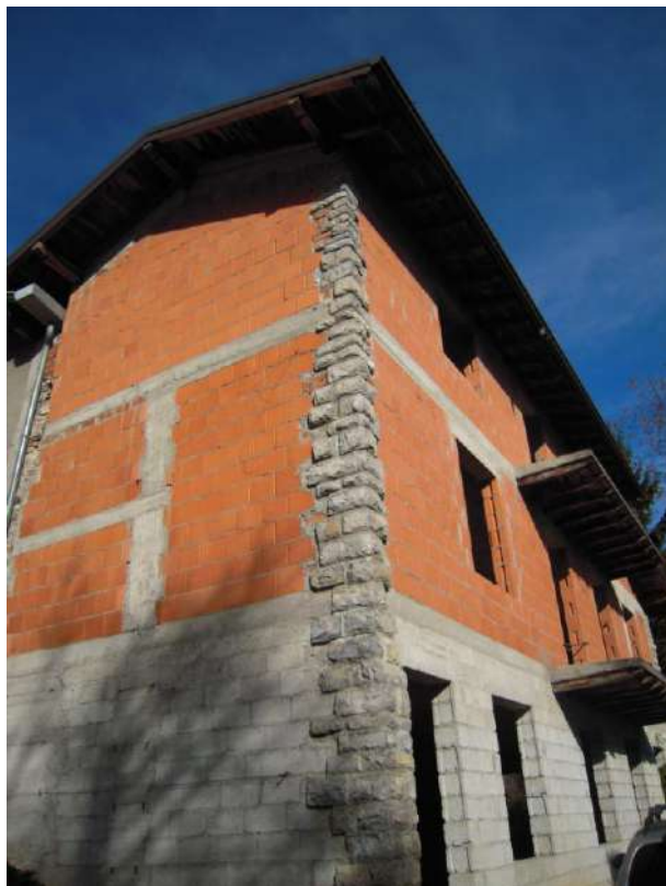
Foto 1 – Vista lato Sud – Ovest immobile
