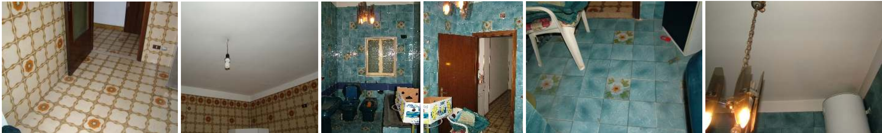
Foto 44-45-46-47 Vano A8 bagno
