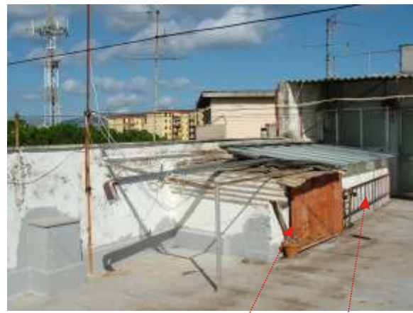
Foto 55-56 Ripostiglio r2 Cortile c1
