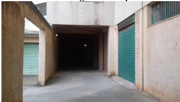
Foto 3: Vista dell'ingresso al deposito
