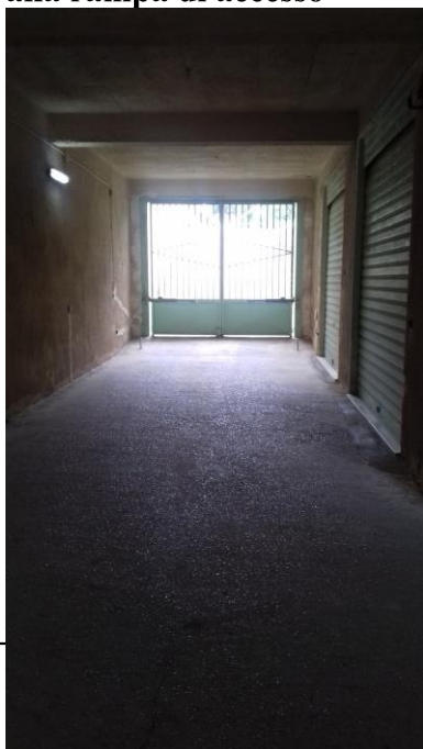
Foto 2: Vista dell'ingresso alla rampa di accesso
