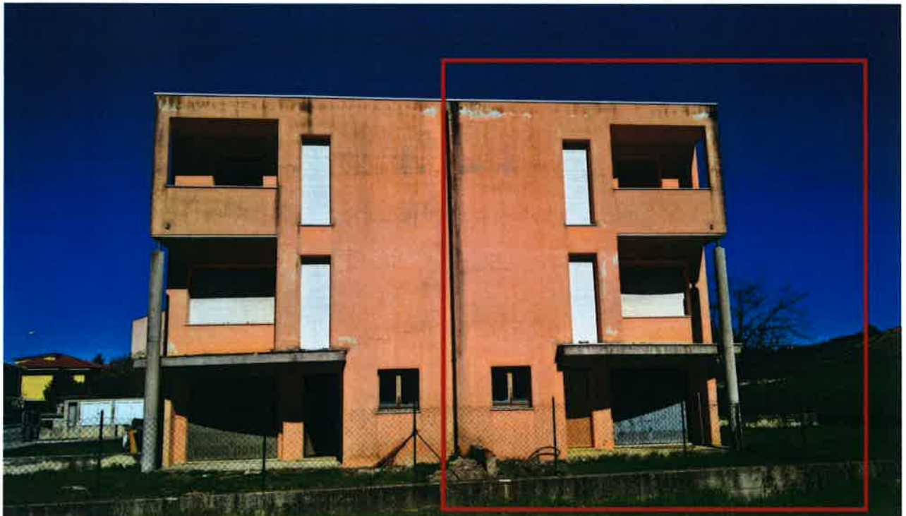
Vista del prospetto Sud dell'edificio, dove sono collocate le unità immobiliari oggetto di stima.
