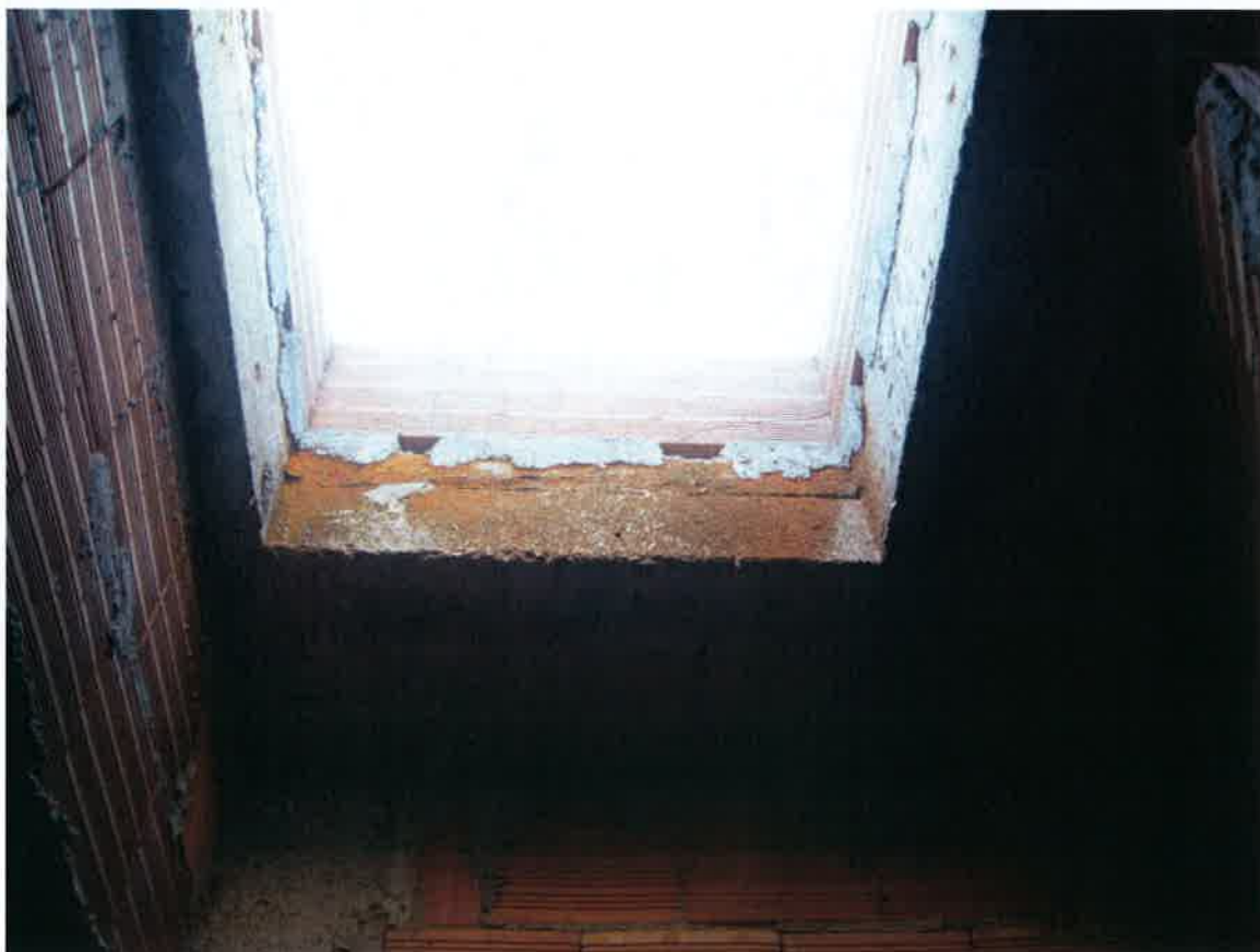
Vista della botola di accesso a tetto
