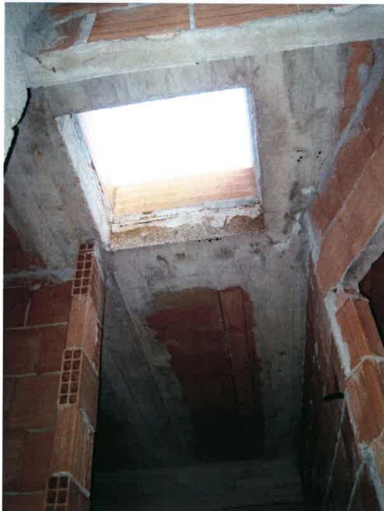
Vista della botola di accesso a tetto
