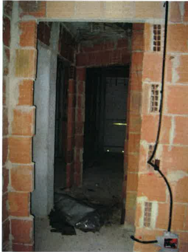
Vista del disimpegno
