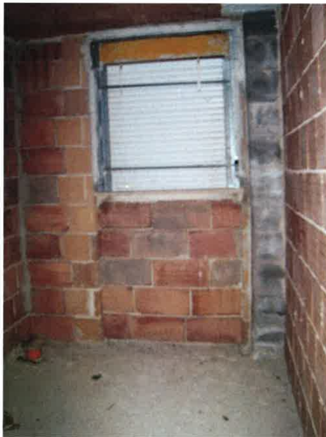
Vista del bagno
