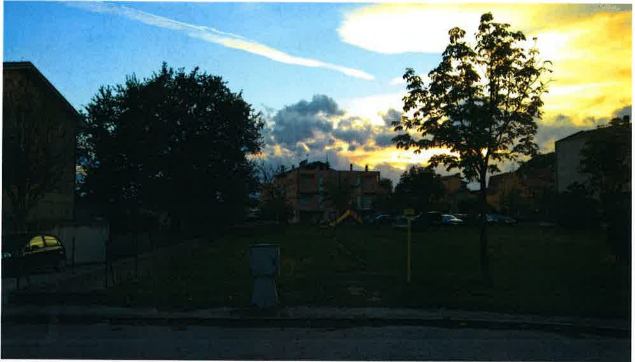
Vista dell'edificio da via Berta con antistante giardino pubblico
