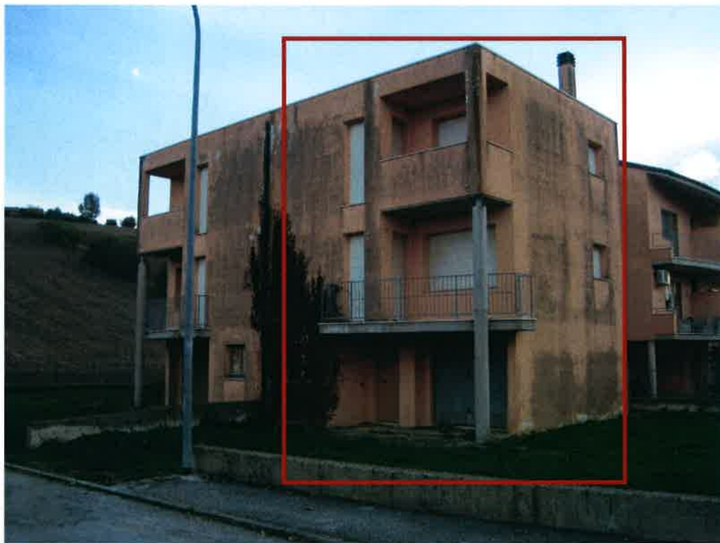
Vista del prospetto Nord dell'edificio, dove sono collocate le unità immobiliari oggetto di stima.
