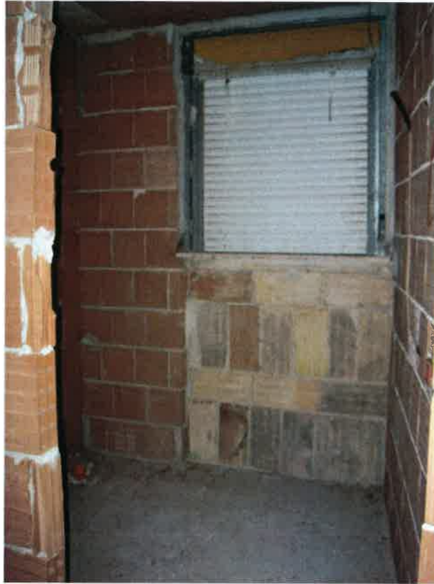
Vista del bagno
