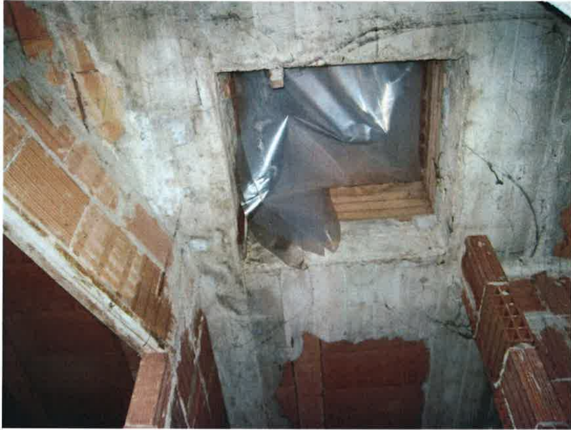
Vista della botola di accesso a tetto
