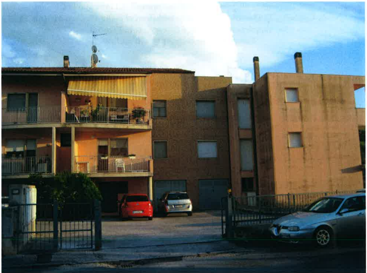
Vista del prospetto Ovest dell'edificio, sul quale è situato il cancello di ingresso.
