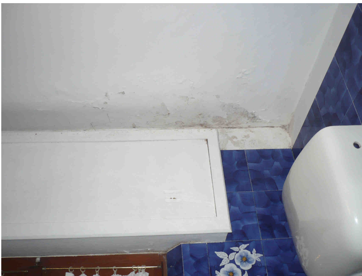
Figura XVII: bagno, macchie di umidità e muffe sul soffitto
