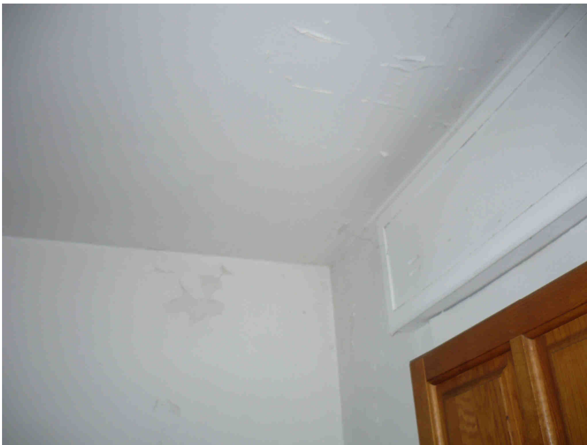
Figura IX: cucina, degrado della tinteggiatura su una porzione del soffitto
