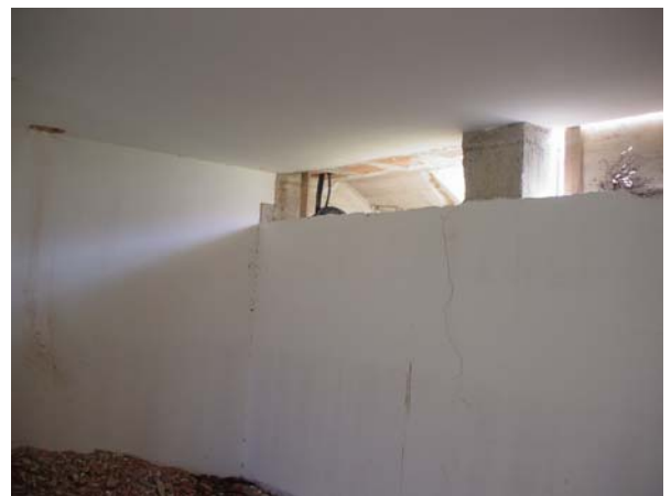
Foto 22 interno seminterrato- unità19
