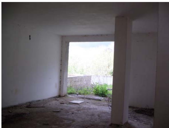
Foto 21 interno seminterrato - unità 19
