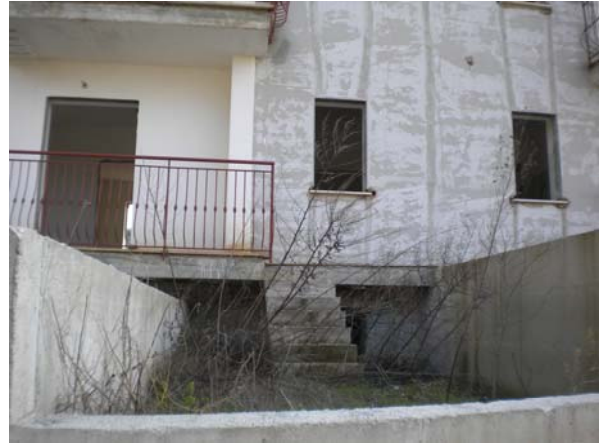
Foto 10 cortile/giardino - unità18 -lato nord
