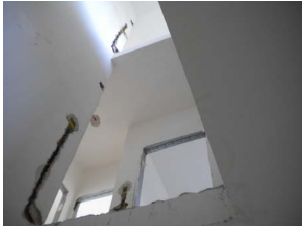
Foto 25 interno botola scala - unità 19
