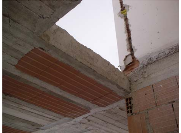
Foto 14 botola scala seminterrato - unità18
