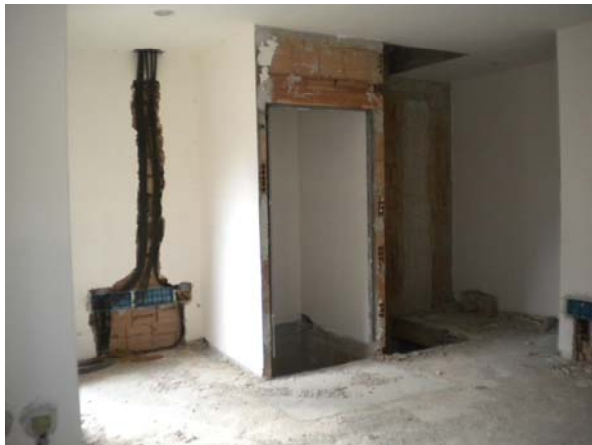
Foto 15 interno soggiorno - unità 18
