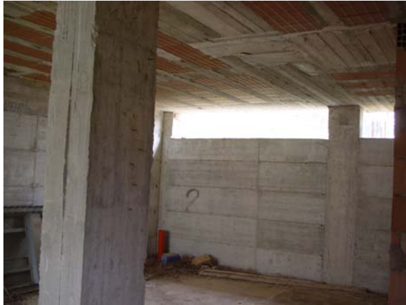
Foto 13 interno seminterrato unità 18
