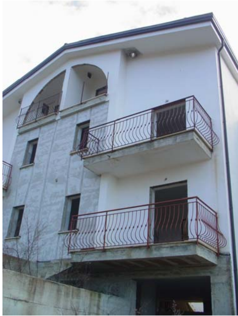
Foto 5 fronte nord su strada interna parco
