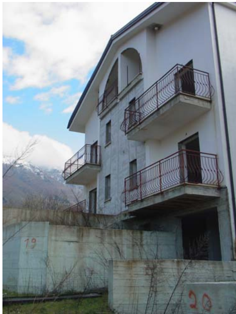
Foto 3 fronte nord su strada interna parco
