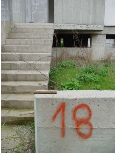
Foto 9 ingresso unità18 lato sud
