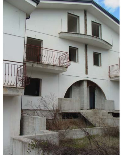
Foto 6 fronte sud ingressi
