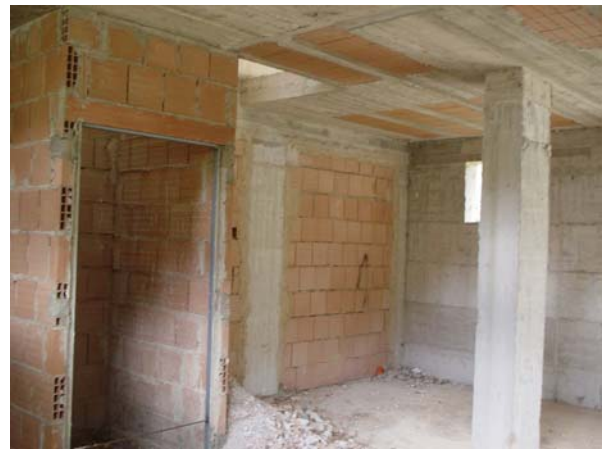
Foto 12 interno seminterrato - unità18
