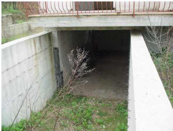
Foto 11 rampa garage unità18 - lato sud
