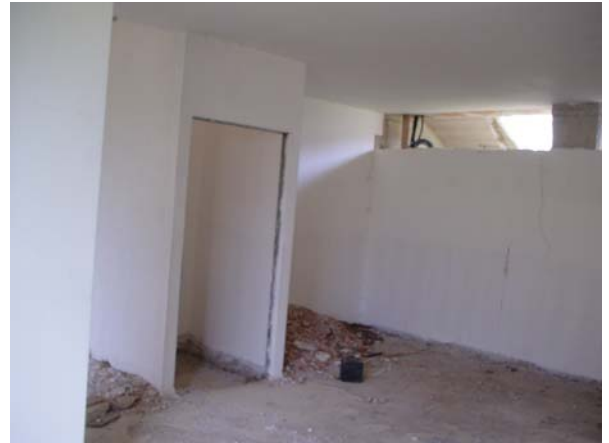
Foto 20 interno seminterrato- unità19
