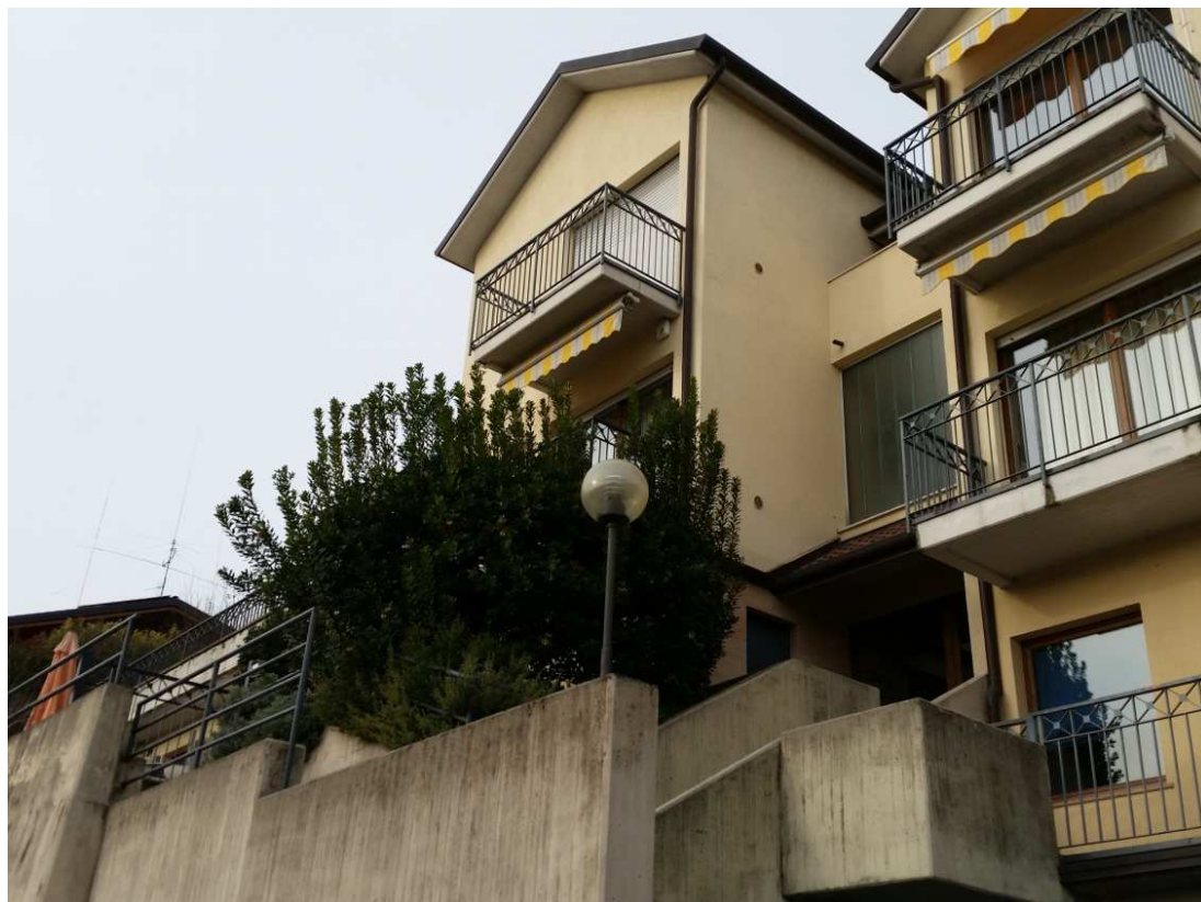
Foto n. 2 - Vista esterna: ingresso comune
