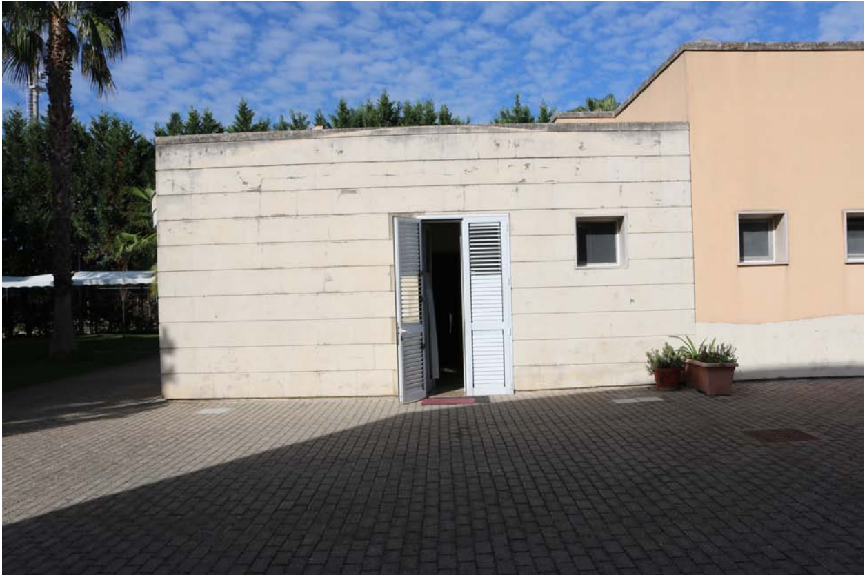
Foto n. 7 Prospetto Locale commerciale
