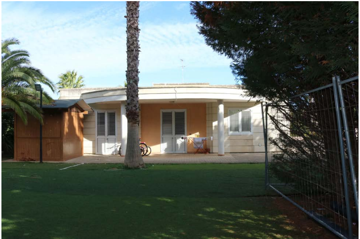
Foto n. 6 Prospetto Locale commerciale
