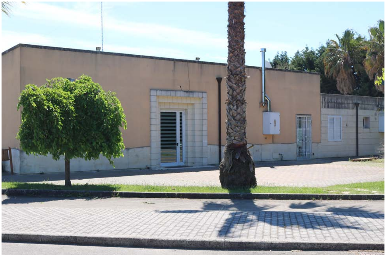
Foto n. 2 Prospetto retro Bar
