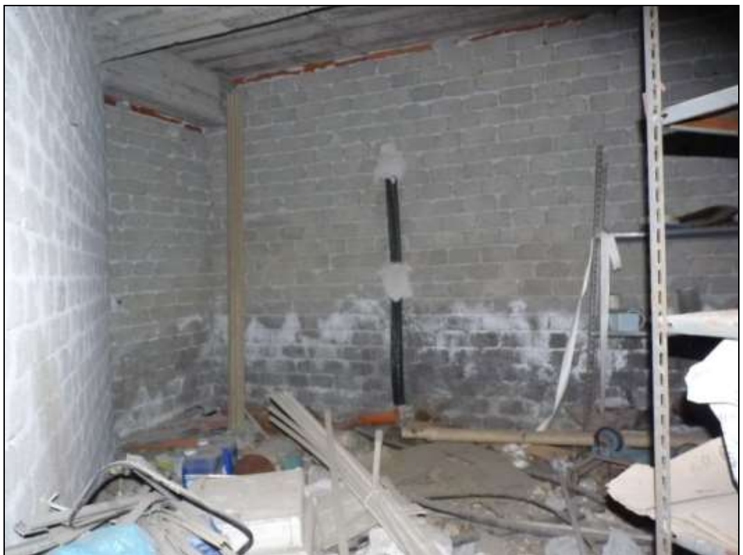
FOTO 26 - Locale deposito al piano seminterrato (immobile 2)
