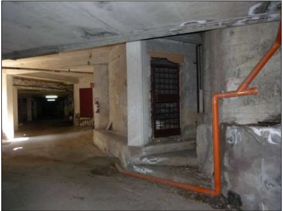
FOTO 25 – Locale deposito al piano seminterrato (immobile 2)
