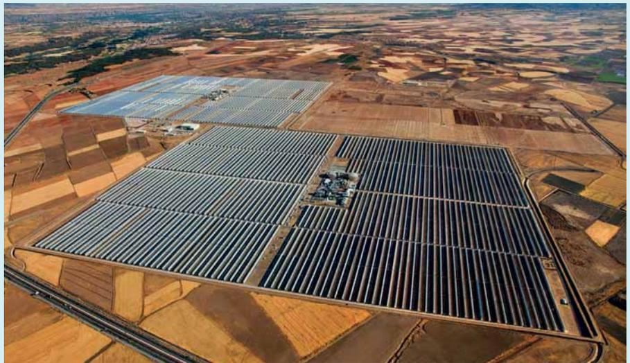
Parabolrinnenkraftwerke Andasol 1 & 2 (je 50 MW an Gesamtleistung und 7 Stunden Energiespeicher) in der Nähe von Guadix in Andalusien
