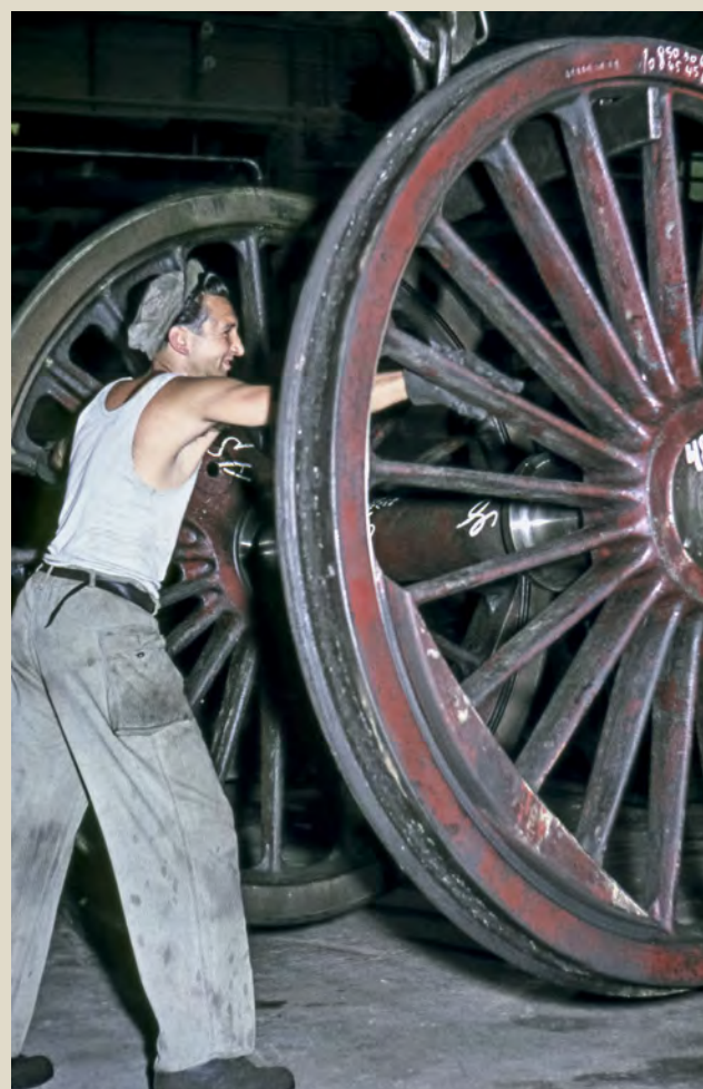
In den frühen 50er-Jahren betreute auch das Bundesbahn-AW Frankfurt-Nied Schnellzug-Dampfloks. Ein Mitarbeiter bekommt es 1953 mit dem enormen 2.000-Millimeter-Treibrad einer 01 zu tun Siegfried Born/Bildarchiv d. Eisenbahnstiftung
