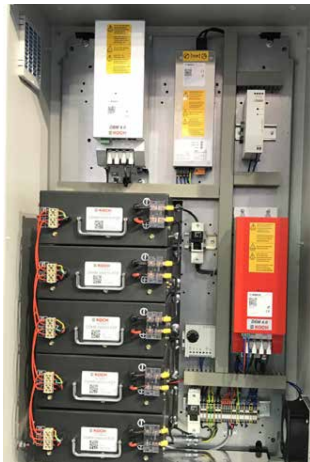
02 Активные системы энергетического менеджмента KTS обеспечивают пиковую мощность намного более 100 кВт и энергию до 1,8 МДж
