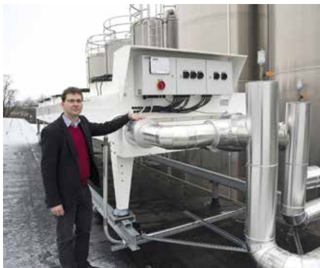
03 Д. т. н. Норберт Фек рядом с новым свободным охладителем на крыше цеха
