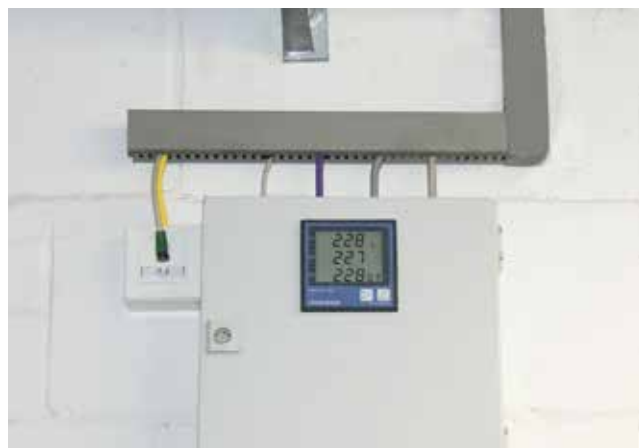
05 Компактный прибор UMG 96RM-E регистрирует данные измерений потребителя и служит в качестве шлюза для визуализации всех потребителей
