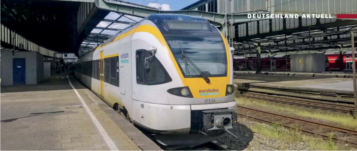
Die Sanierung des Duisburger Hauptbahnhofs wird erst 2019 starten (Foto vom 28. Mai 2017) M. Wehmeyer
