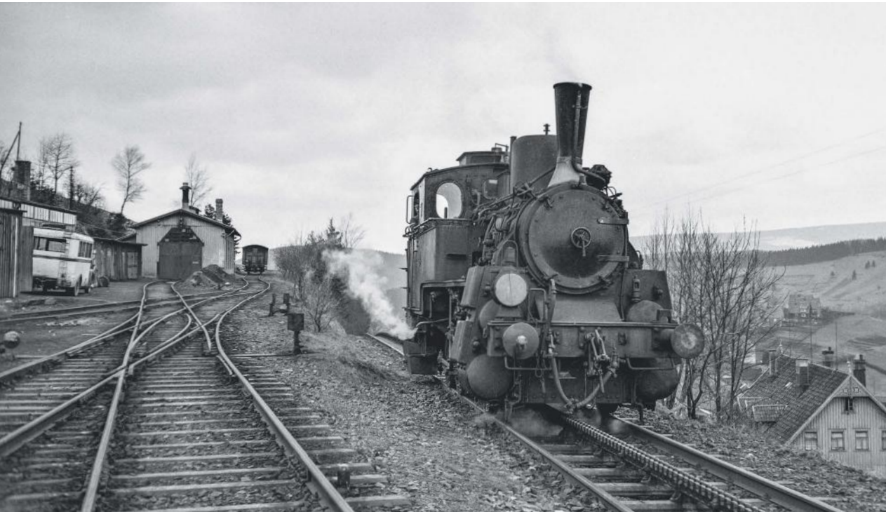
Die Bergstation: Links Rangiergleise und der Lokschuppen, rechts geht es sofort mit der Maximalneigung zu Tal, wo etwa 300 Meter weiter schon der Haltepunkt Schwalbenherd folgt
