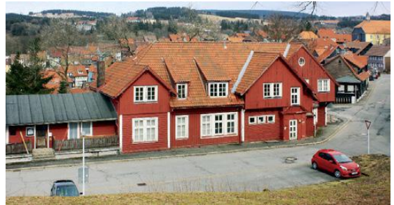
Das Empfangsgebäude der Kleinbahn: Wo der Pkw parkt, war der Prellbock eines Ladegleises R. Heym
