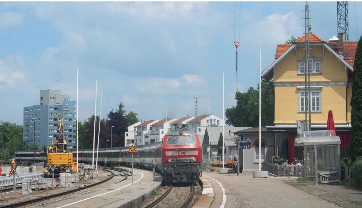
In Leutkirch ist der Bahnhofsumbau am 25. Mai 2017 im vollen Gange. Am 24. November 2017 wurden die neuen Bahnsteige in Betrieb genommen. Im Bahnhofsgelände befindet sich eine Gastwirtschaft
