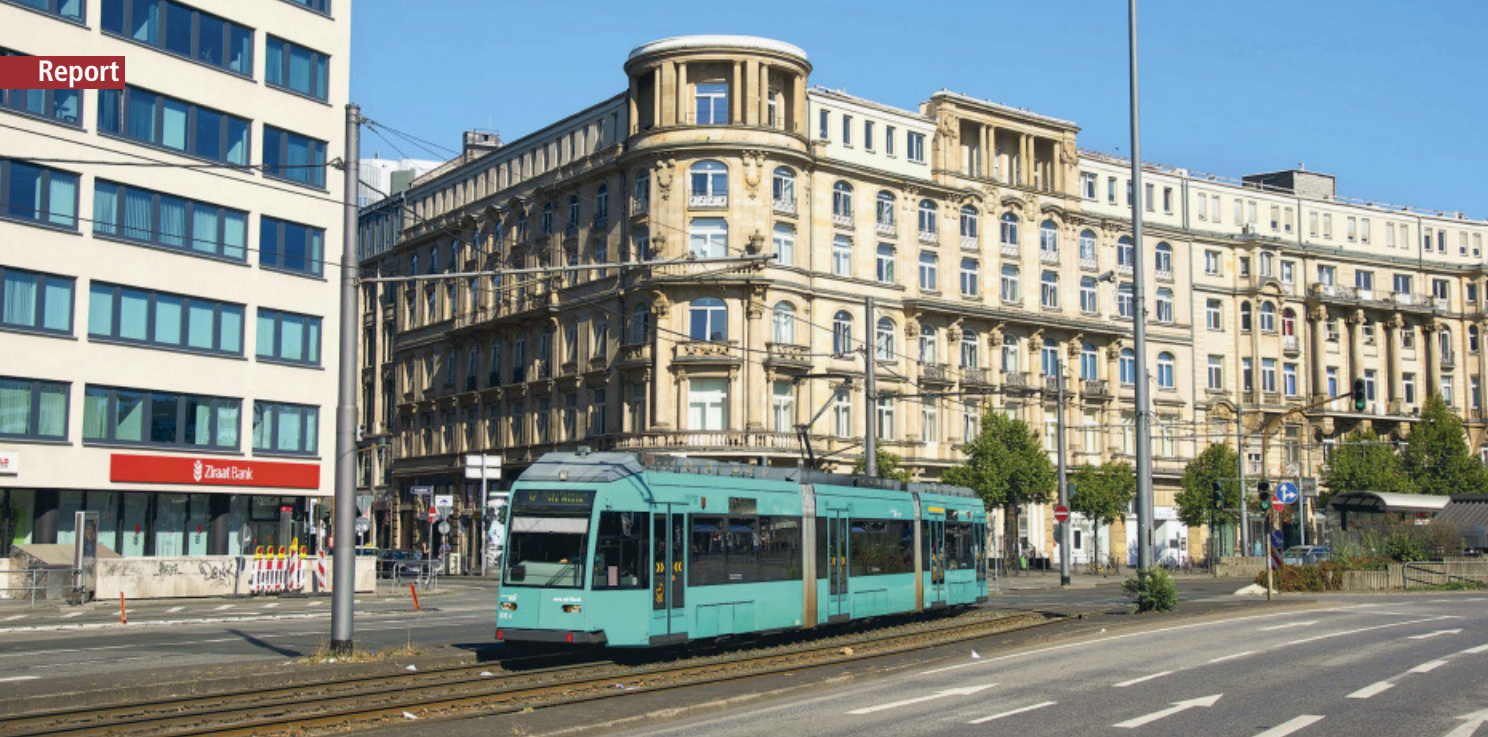
Der bisher vom Autoverkehr geprägte Bahnhofsvorplatz in Frankfurt (Main) wird neu gestaltet. Die Straßenbahnhaltestelle bekommt dabei ein zusätzliches Gleispaar, um den zusätzlichen Verkehr durch Taktverdichtungen und weitere Linien aufnehmen zu können
