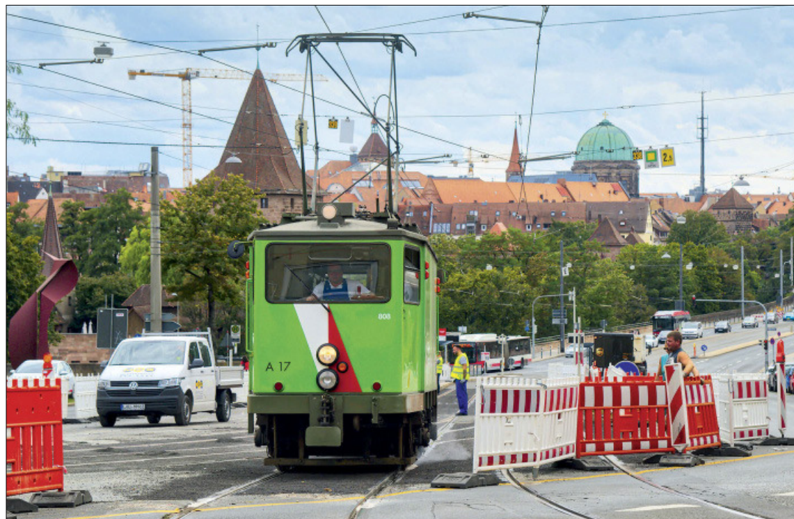
Nürnberg: Der von der Üstra in Hannover ausgeliehene Schörling-Schleifwagen A 17 soll bald wieder durch den reparierten Windhoff-Schleifwagen A16 abgelöst werden, am 3. September 2020 stand aber noch die Abnahmefahrt über die Baustelle am Neutorgaben an FREDERIK BUCHLEITNER
