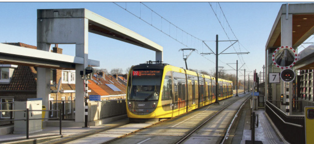
Am 30. Dezember 2019 erreicht eine Doppeltraktion, angeführt von Tw 6007, der neuen Niederflurstraßenbahn von Utrecht die aufgeständerte Station Vaartsche Rijn NICOLAI SCHMIDT
