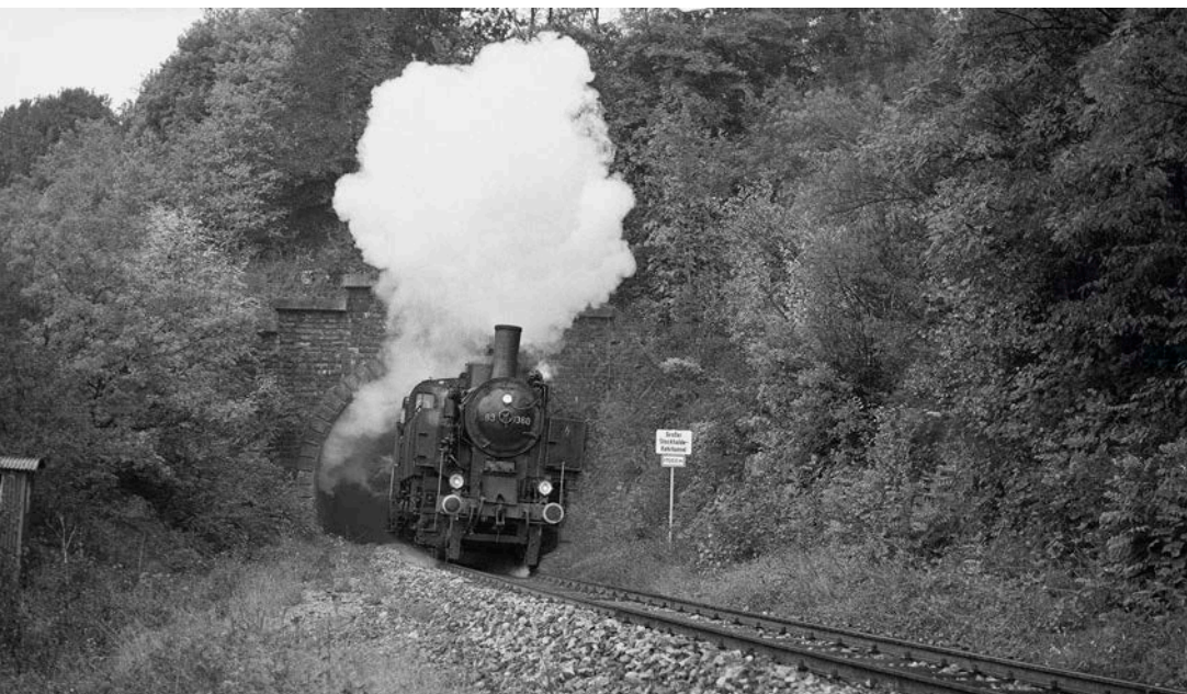
Genau 1.700 Meter lang ist der Große Stockhalde Kreiskehrtunnel. Hier kreist die Strecke in einem Radius von 350 Metern und gewinnt dadurch 15 Meter an Höhe gegenüber den an dieser Stelle tiefer liegenden Bahnhofsanlagen von Grimmelshofen (Foto mit 93.1360, August 1979)
