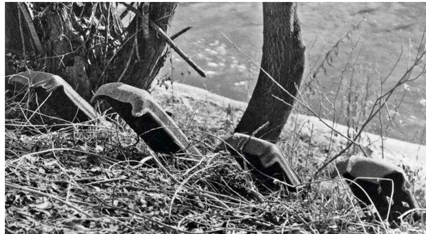
Weiterverwertung auch bei der Landschaftsgestaltung: Nicht mehr benötigte Stahlschwellen wurden in den 1930er-Jahren verwendet, um den Hang an der Apfelstädt zu befestigen
