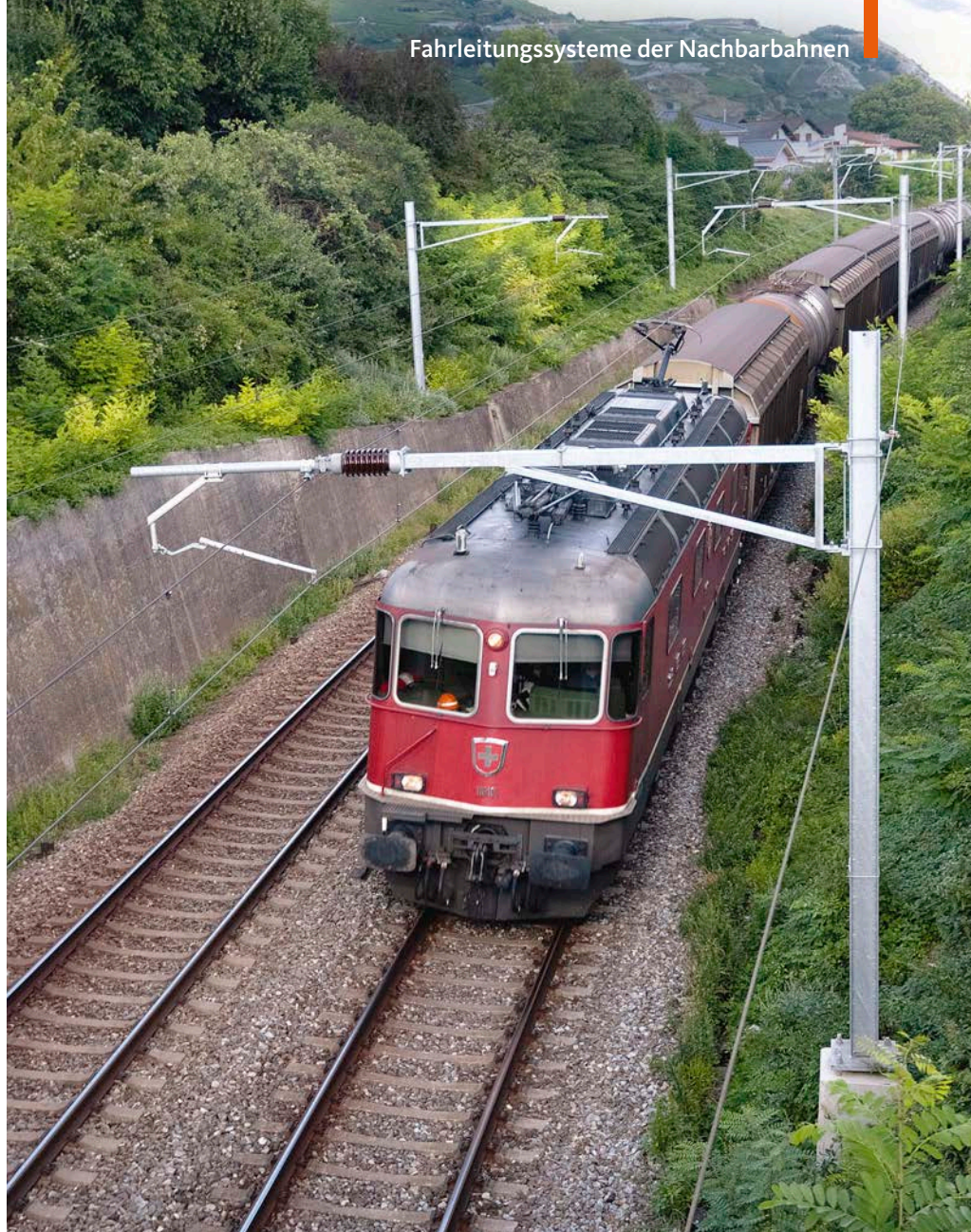
Diese bei Sion im August 2012 aufgenommenen modernen SBB-Ausleger, deren kompakte Bauform nur einen Isolator benötigt, sind noch nicht als Modell verfügbar Michael U. Kratzsch-Leichsenring (3)
