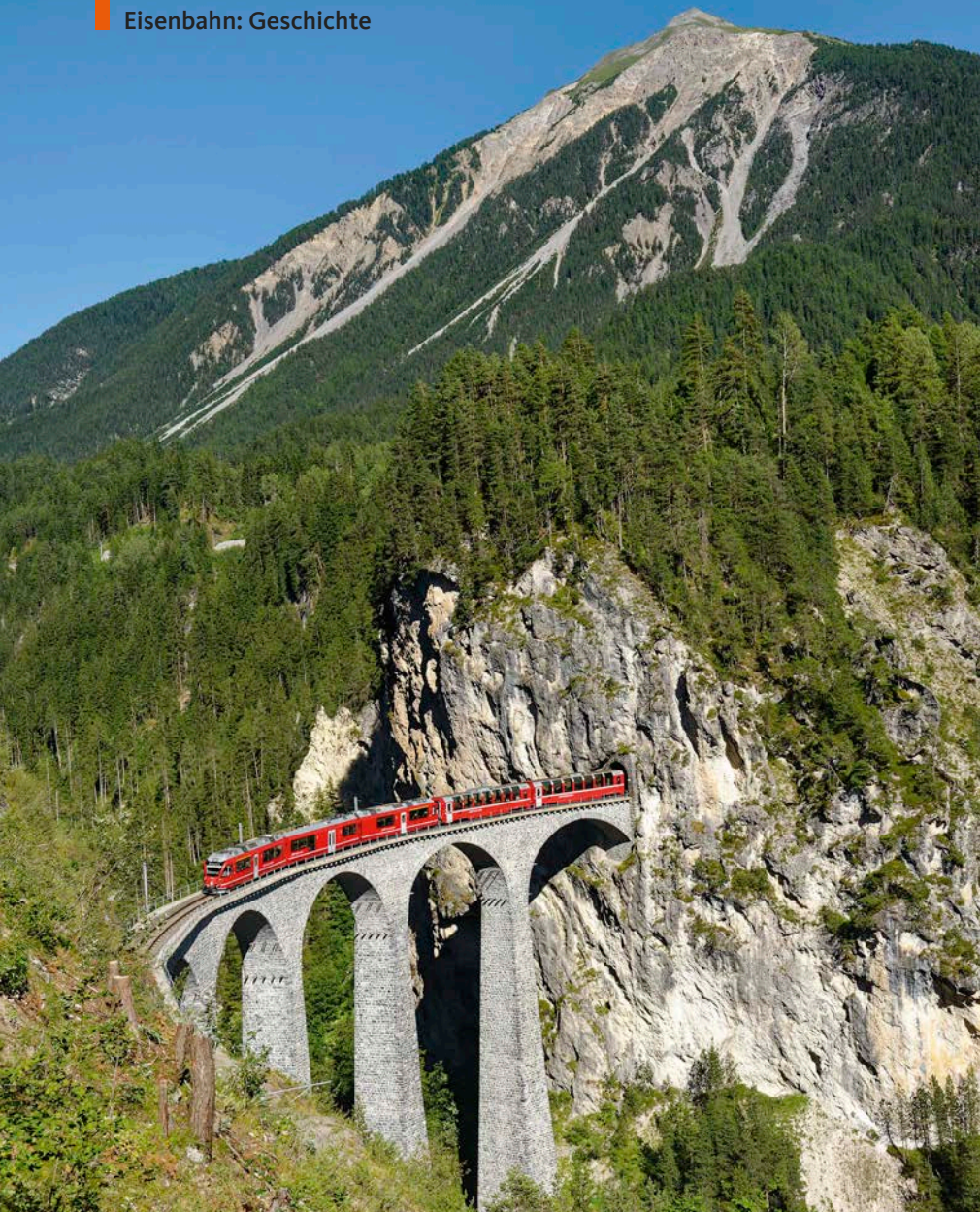
Der „Bernina Express“ der vierten Generation besteht aus einem Allegra-Triebwagen und klimatisierten Panoramawagen. Am 2. August 2013 passiert ein solcher Zug den Landwasser-Viadukt, über dem sich die 2.623 Meter hohe Muchetta erhebt
