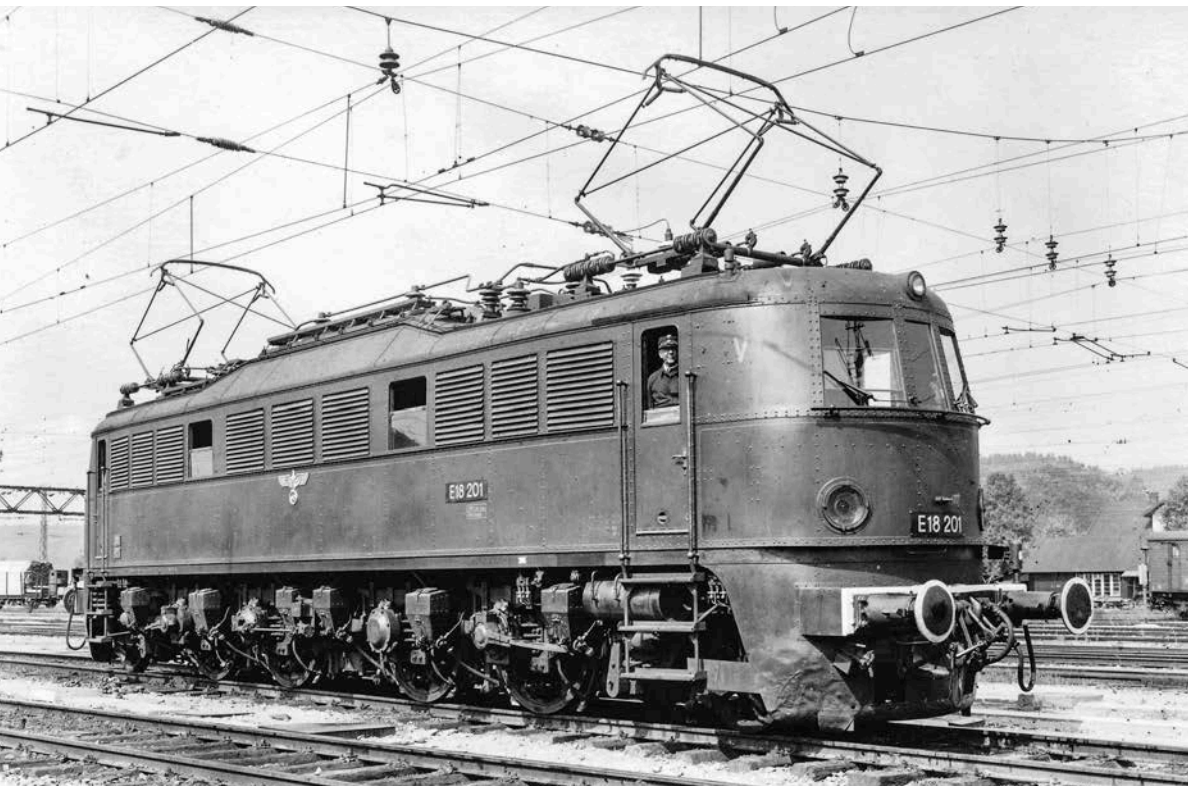
E 18 201 am 3. Juni 1942 in Attnang. Optisch unterschieden sich die E 18 2 von den E 18 durch das Fehlen der Lüftungsgitter unterhalb des Mittelgurts und die Anzahl der Maschinenraumfenster C. Bellingrodt/Slg. OS
