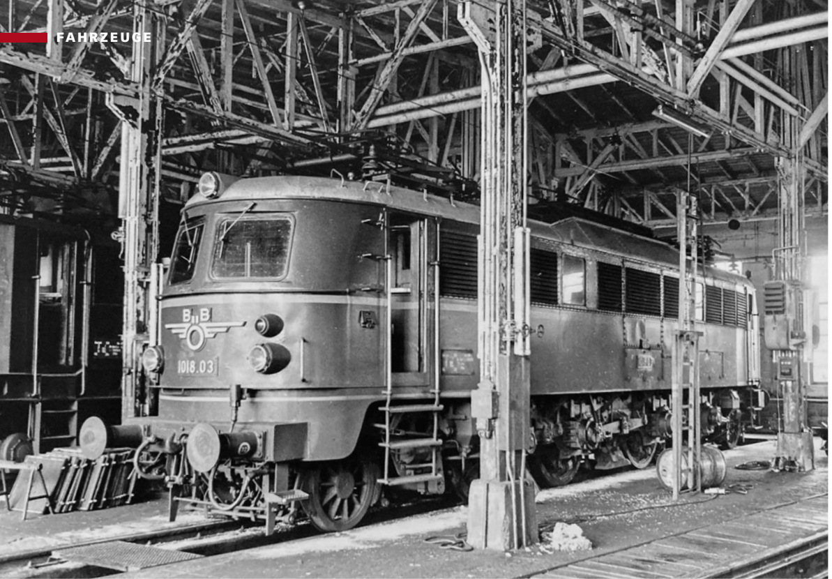
In den 1960er-Jahren erhielten die 1018/1118 vergrößerte Fenster für eine bessere Rundumsicht und ein rotes Rücklicht vom Typ TF 220 2 b. 1018.03 ruht sich am 2. August 1975 in der Zfl Linz aus Herbert Stemmler
