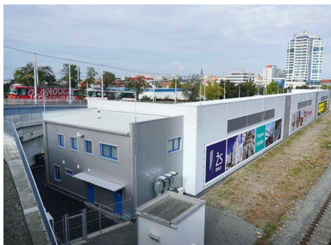
Olomouc (Ölmütz): Das neue Tramdepot liegt direkt neben dem Bahnkorridor. Daneben befindet sich die Rampe zur Tovární-Brücke, hier mit einem Zug der Linie 4 nach Pavlovičky ANDREW THOMPSON
