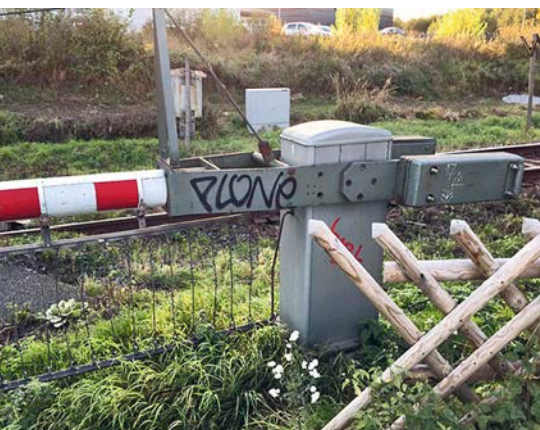
Das Vorbild ist diese etwas ältere elektrische Schranken-antriebs-säule
