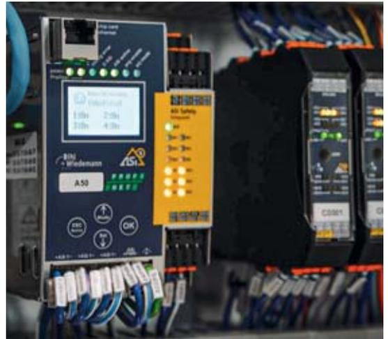
ASI-5/ASI-3 Profinet Gateway BWU3862 (l.) und selbstkonfigurierende E/A-Module ASI-5 BWU3884 (r.).
