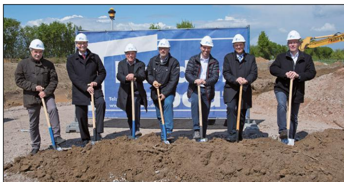
Die Verantwortlichen von Print Equipment setzen den ersten Spatenstich für das neue Firmengebäude.
