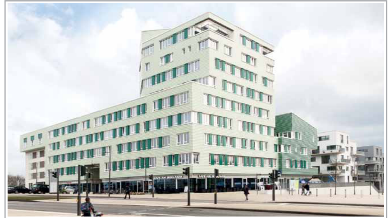
Mit 1,3 Millionen Euro beteiligten sich Anleger über Exporo.de an der Refinanzierung eines neun geschossigen, voll vermieteten Ärzte- und Gewerbezentrums mit ca. 5.000 m 2 Wohn- und Gewerbefläche
