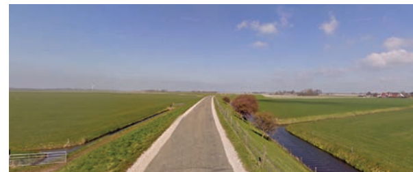
Dijkwegen: Westfriese Omringdijk
