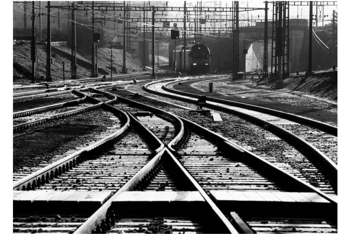
Sanierungsbedarf besteht unter anderem bei Gleisen, Weichen und Oberleitungen.
