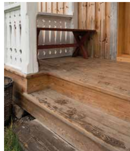
Her var der en betongtrapp. Nå er det blitt plattning og trapp i tre, sånn det opprinnelig var.
