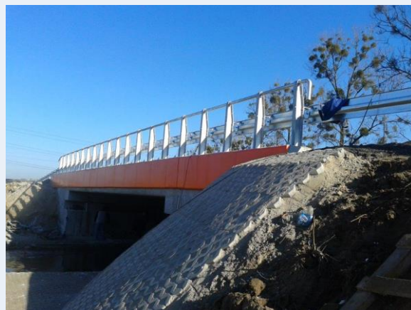
Rozbudowa drogi i przebudowa mostu Kolonia Popielawska
