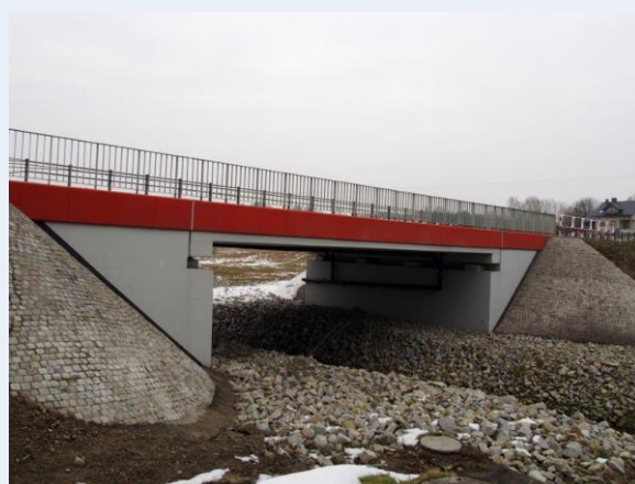
Przebudowa mostu drogowego ciągu ul. Niepodległości w Rybniku
