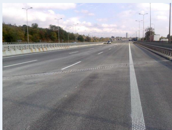
Wymiana dylatacji A4
