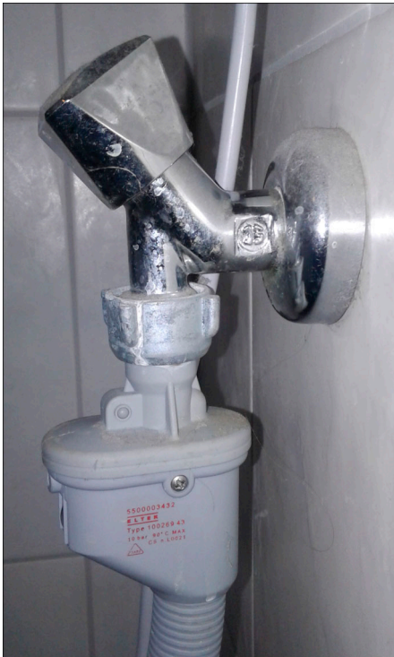
Abbildung 10.2 Der sogenannte Aquastop einer Waschmaschine (Quelle: https://commons.wikimedia.org/wiki/File:Aquastop_20200522_212938.png )
