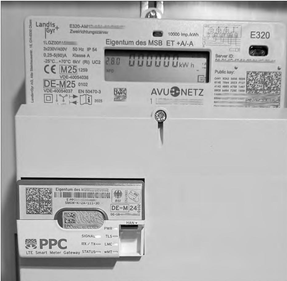
**Abbildung 4.28** Dieser Stromzähler verfügt links unten über ein Mobilfunkmodul zur Datenübertragung. Diese funktioniert dank externer Antenne sogar im tiefsten Keller. Smart, oder?
