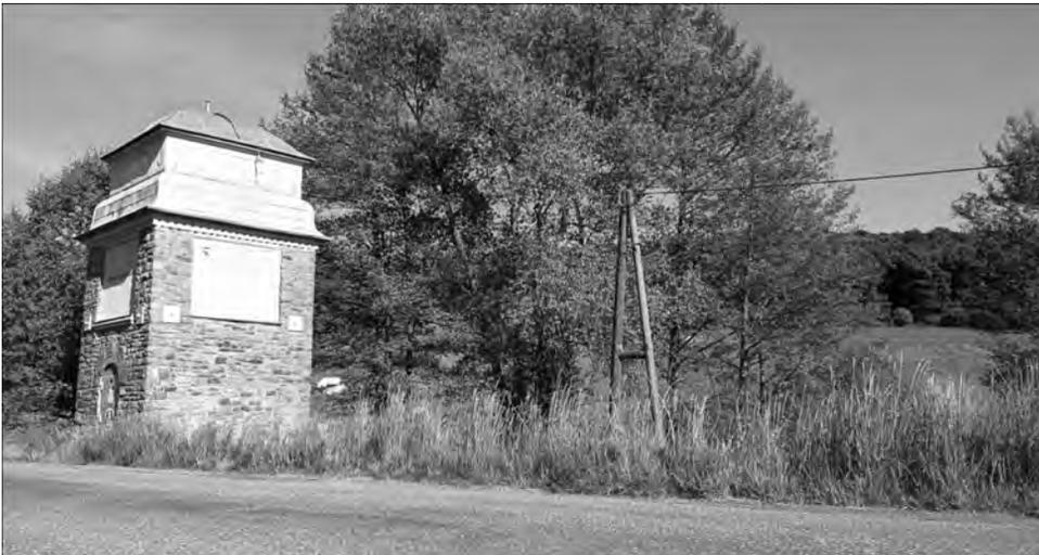
**Abbildung 9.2** Dieses Schalthaus aus den 1920er-Jahren steht unter Denkmalschutz. Aufgabe: Mittelspannung (10–20 kV) in Niederspannung (400 V) transformieren.
