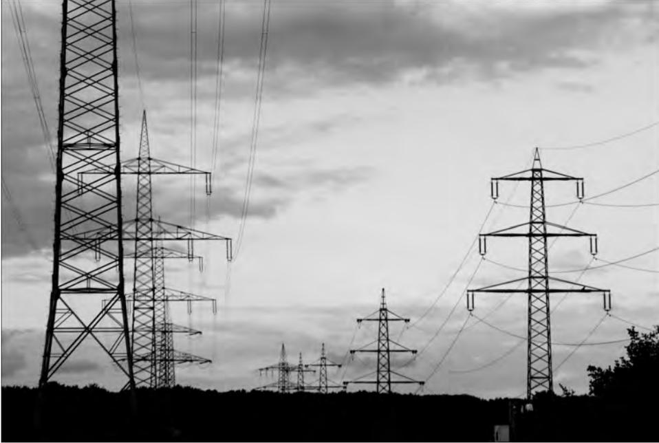
**Abbildung 9.1** Zwei parallele Leitungen in der Nähe der Autobahn A1 bei Kamen: links Höchstspannung, rechts Hochspannung. Die Höchstspannungsleitung führt unter anderem von einem Gaskraftwerk zu einem Stahlwerk.
