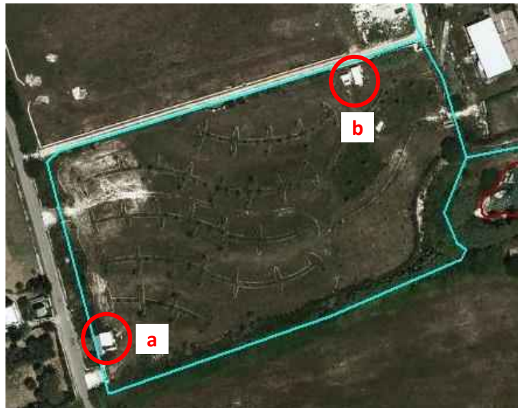
Figura 7 - STRUTTURE INSISTENTI NELLA P.LLA 1094
