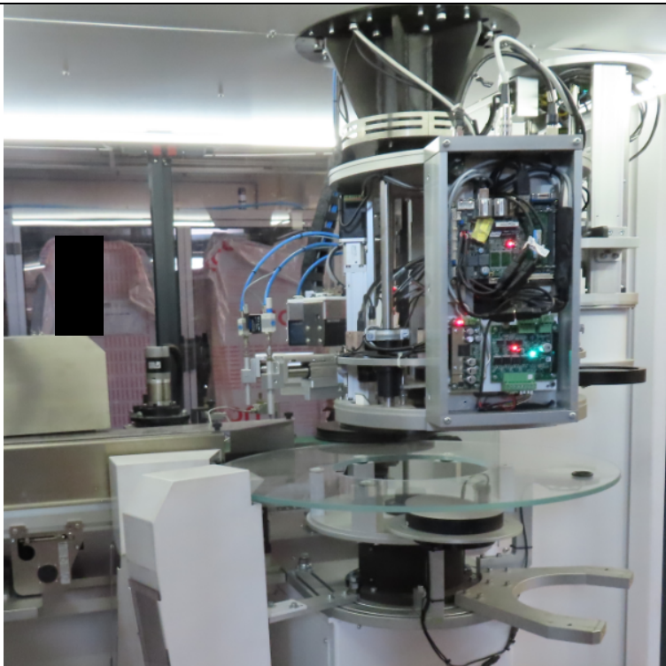
Vista interna zona di controllo prodotto con le varie stazioni
