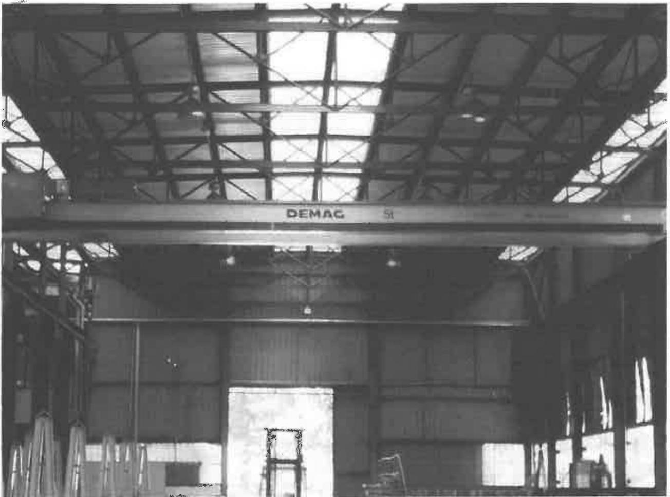
**CARROPONTE DEMAG ZKKE DA 5000 KG SCARTAMENTO 17,53 M
