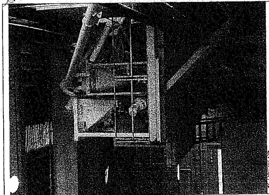
FOTO N° 42 - Lotto "A" - Impianto di betonaggio per graniglie capannone A
