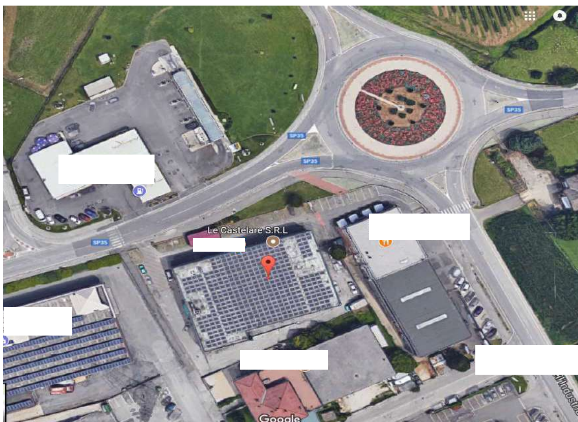
Immagine dall’alto dell’immobile su cui è installato l’impianto fotovoltaico
