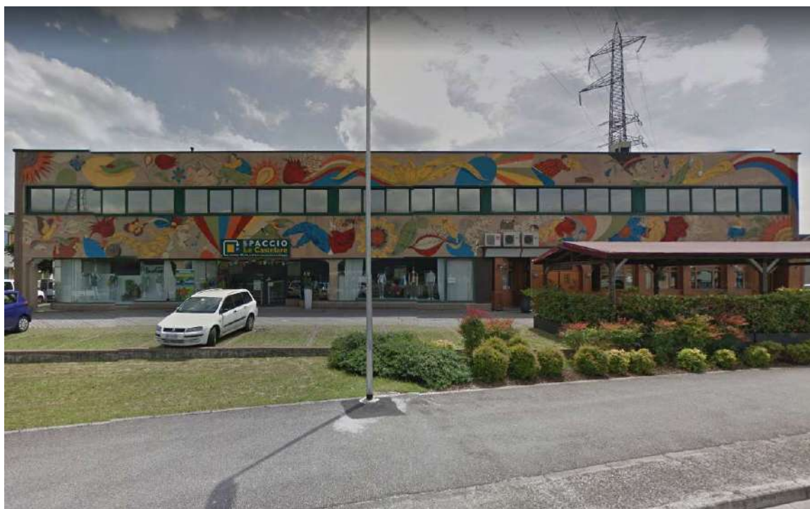
Immagine frontale dello stabile sulla cui copertura è installato l'impianto fotovoltaico
