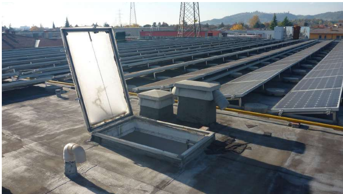
Accesso alla copertura da locale bagni al secondo piano dell'immobile.
