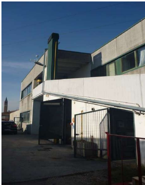
Cavidotto esterno e locale tecnico ove sono posizionate apparecchiature elettriche
