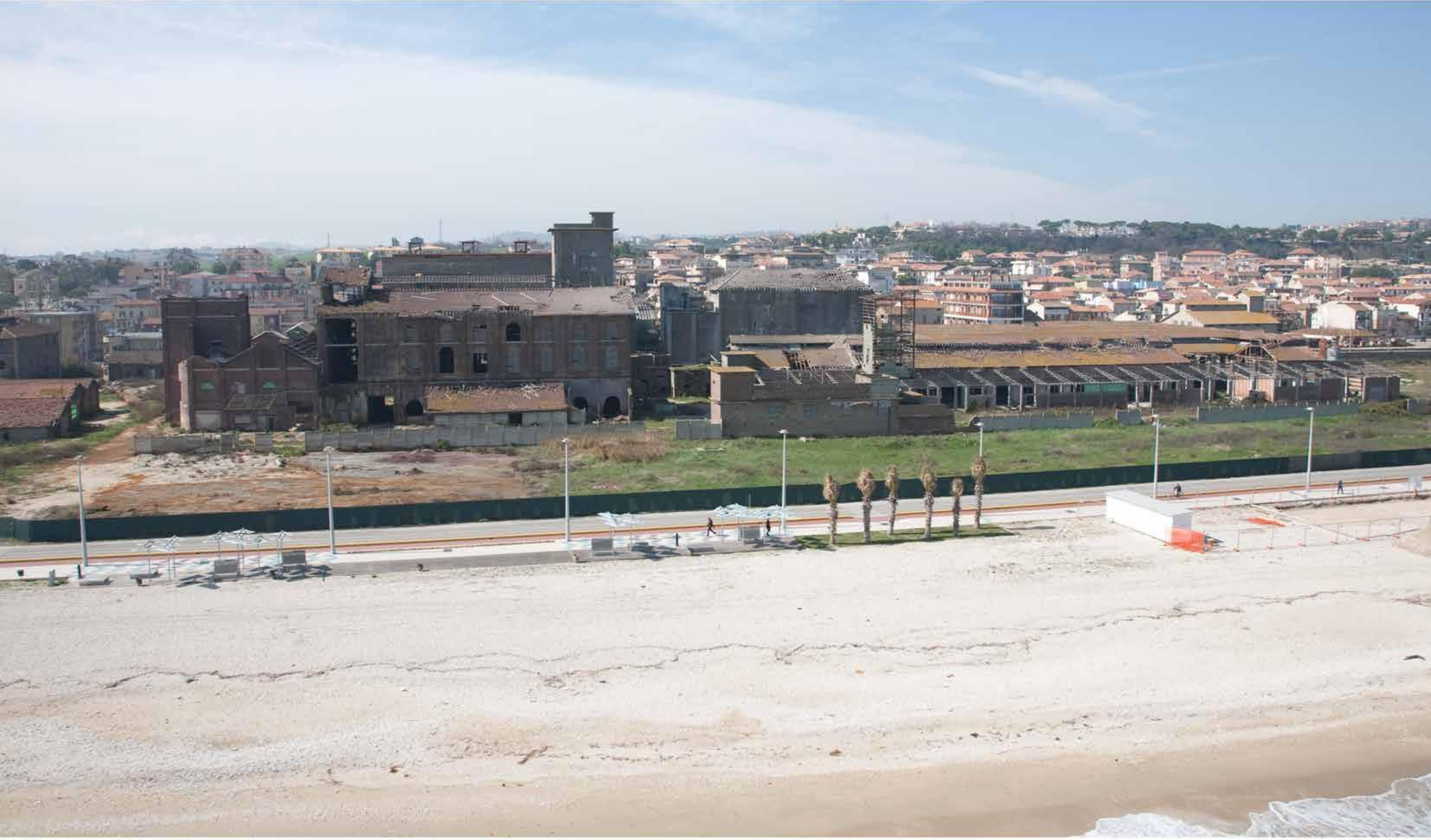
RILIEVO FOTOGRAFICO: ex-fim prima della demolizione
