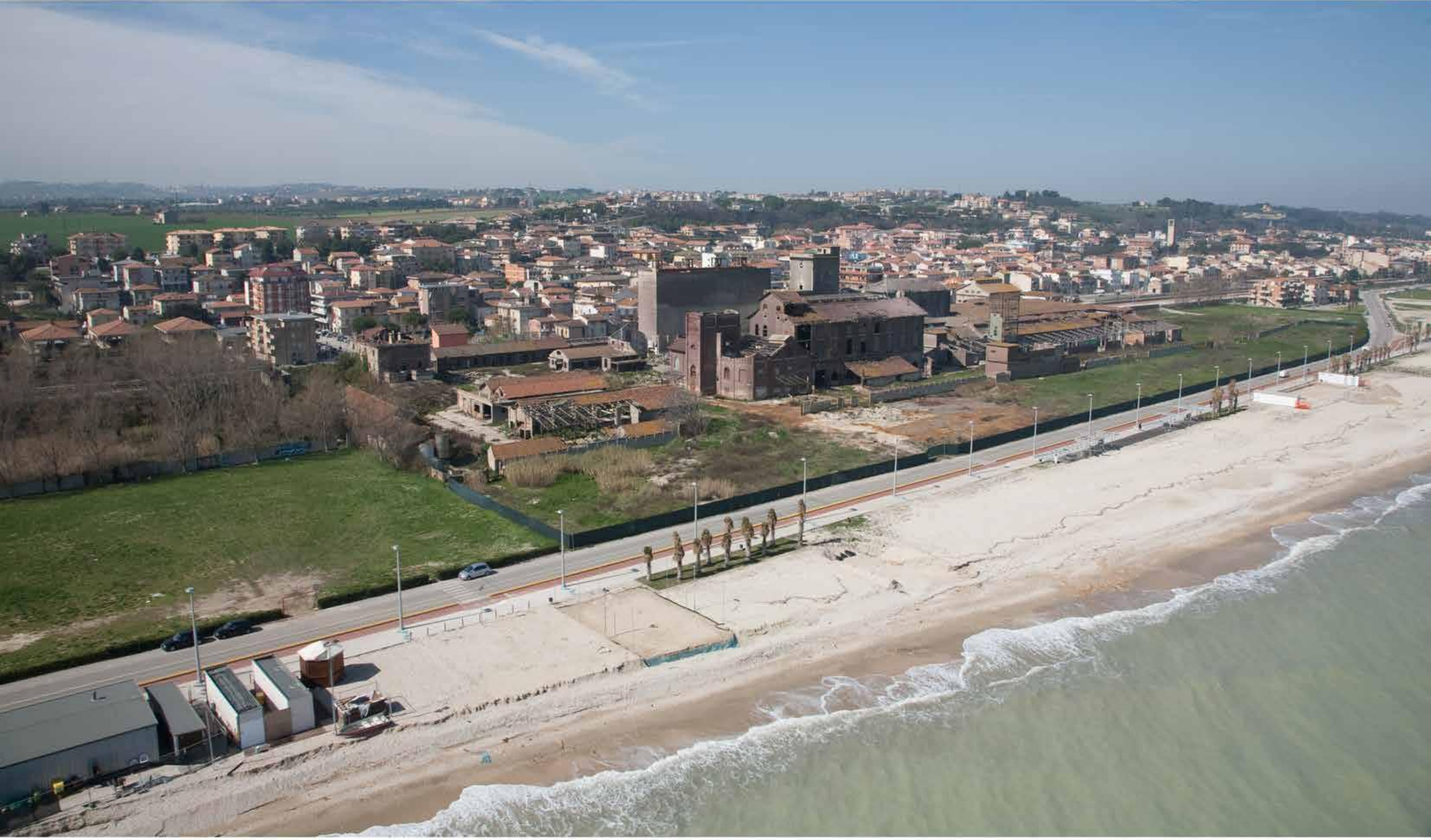
RILIEVO FOTOGRAFICO: ex-fim prima della demolizione
