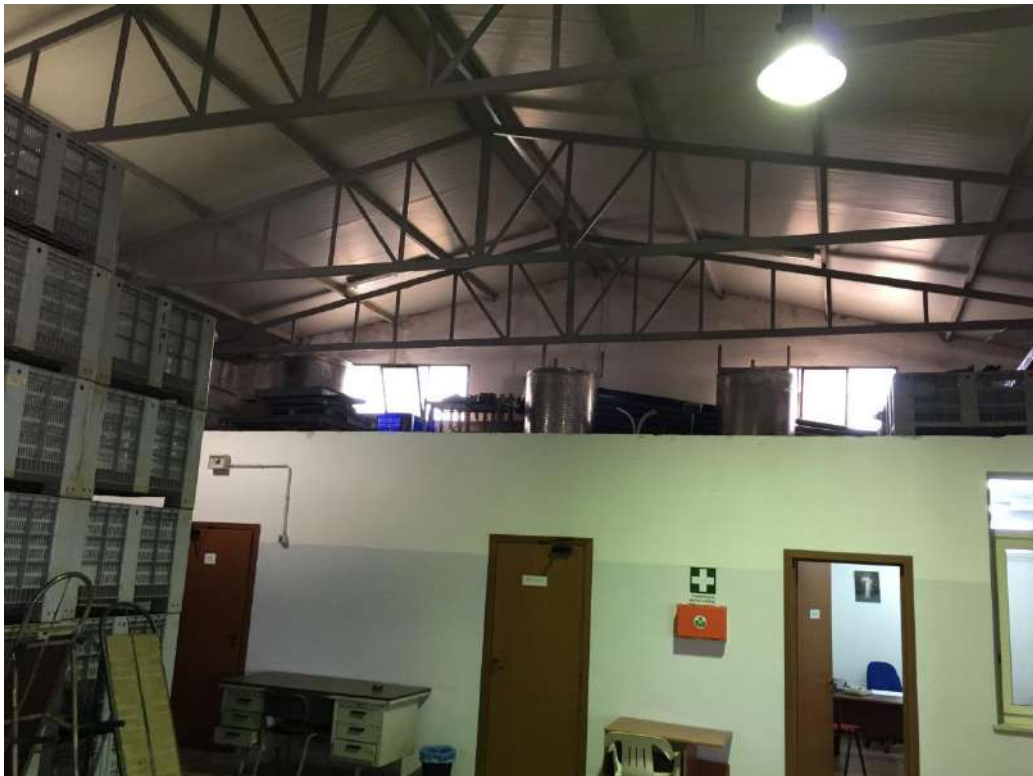
Interno Frantoio vista uffici e servizi
