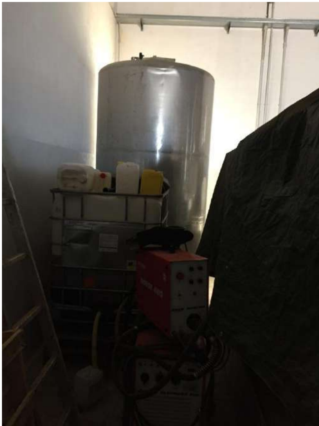
5 N. 1 silos in acciaio da 50 hl
