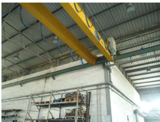
FOTO 12 – CAPANNONE CORPO C – PARTICOLARE CARROPONTE
