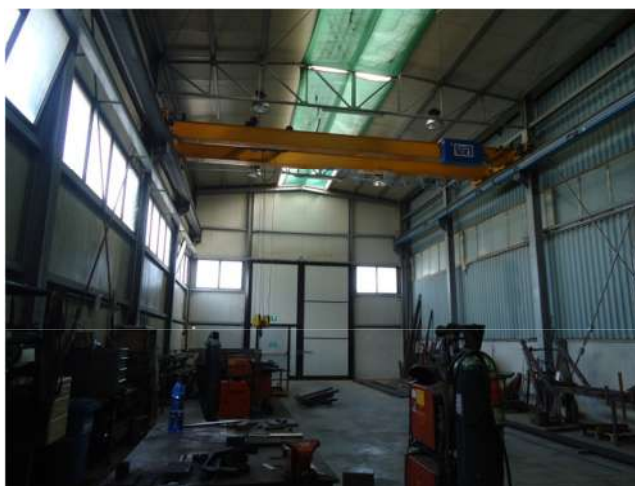
FOTO 11 – CAPANNONE CORPO B – PARTICOLARE CARROPONTE
