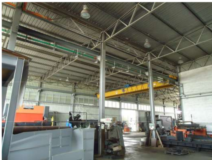
FOTO 13 – CAPANNONE CORPO C
