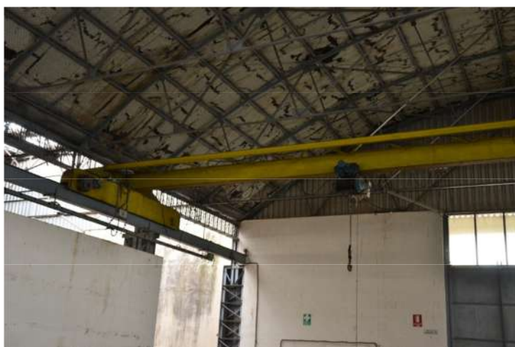
FOTO 9 – CORPO B CAPANNONI - INTERNO – PARTICOLARE CARROPONTE
