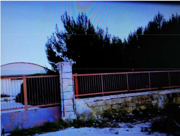
FOTO 1 – PARTICOLARE MURO DI CINTA E INGRESSO AL LOTTO
