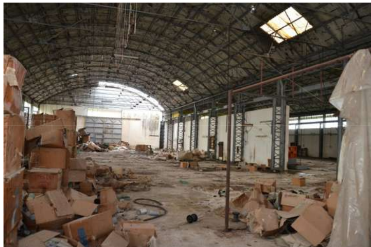
FOTO 8 – CORPO B CAPANNONI - INTERNO
