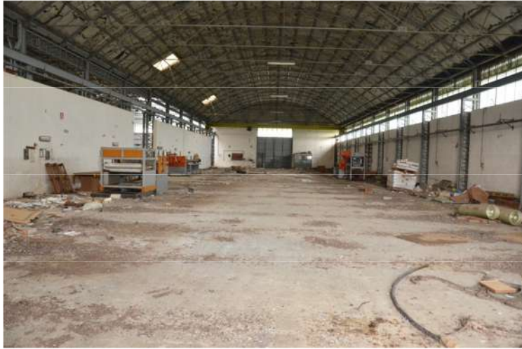
FOTO 10 – CORPO B CAPANNONI - INTERNO
