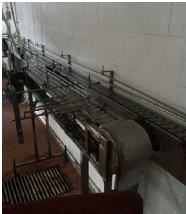
25. Prolungamenti di nastro trasportatore (Edificio A).
