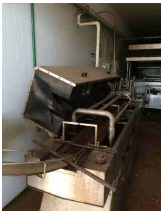
36. Prolungamento rullo trasportatore di cui al n. 25 dell'inventario (Sala lavaggio - Edificio A).
