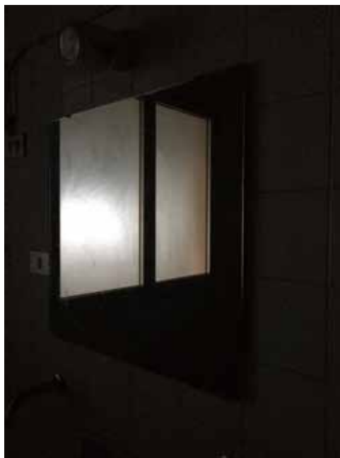
109. N. 2 specchi 0,65 m x 0,60 m in cattive condizioni (Edificio A - 1° Piano)
