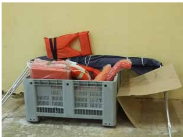
329. N. 8 salvagenti a giubotto, n. 2 ciambelle di salvataggio, n. 1 estintore a polvere da 1 kg, n. ancorotto e n. 1 sacchetto con razzi (Edificio B - Piano cantinato)
